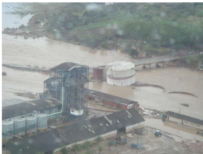
Figura 11 - Usina Laginha no município de União dos Palmares, durante a cheia de junho de 2010, no rio Mundaú. Destaque para o local onde funcionava o tanque de álcool (CPRM, 2010).
