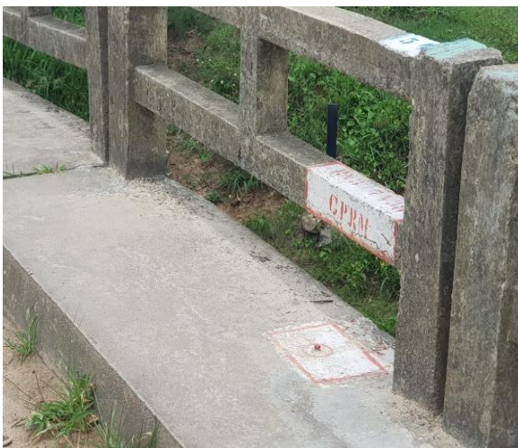
Figura 6 - RN em ponte
