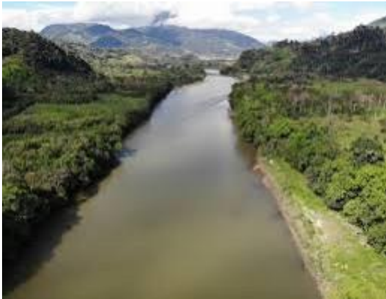
Figura 1 - Controle Hidráulico de Canal
