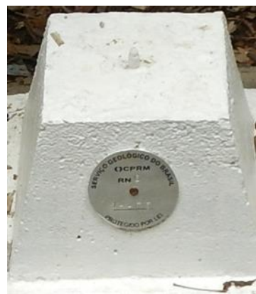
Figura 7 - Chapa de alumínio de topo e lateral
