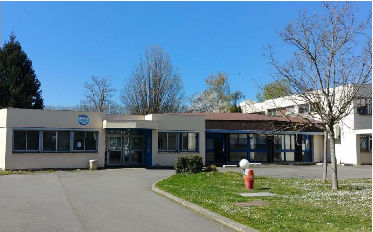
Figura 14 – Vista da entrada do LEGOS em Toulouse.
