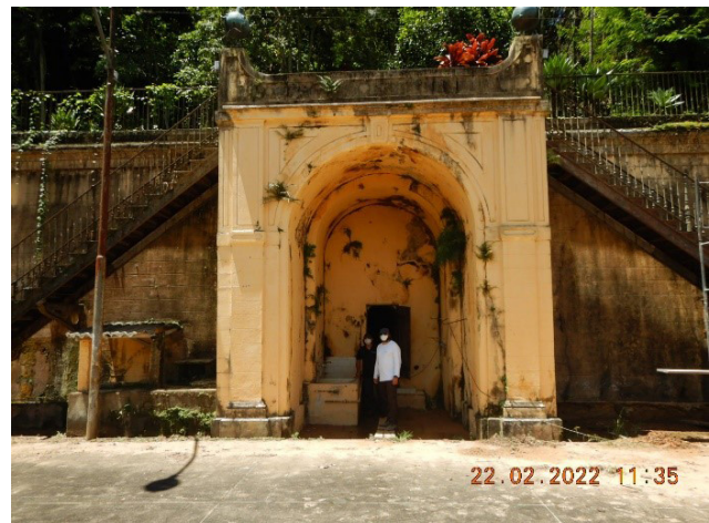
Foto 8 - Bica de água mineral junto ao muro
