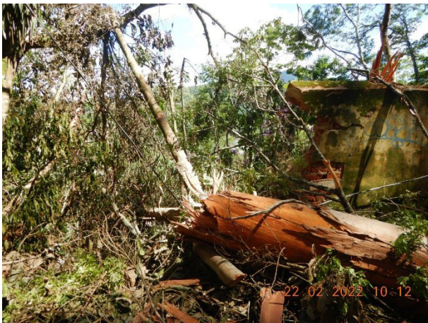
Foto 5 - Muro do Palácio danificado pelo deslizamento ocorrido na residência da rua Monsenhor Teodoro Rocha, 280
