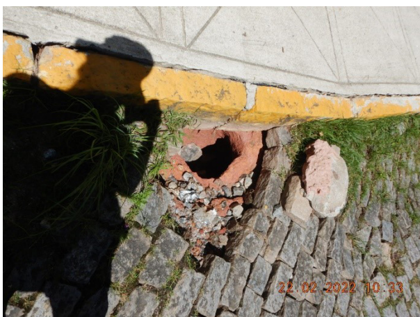
Foto 12 - Início de piping , meio fio solto e rua colapsando no morro dos Milionários.
