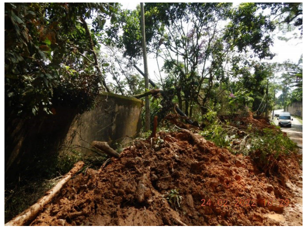
Foto 5 - Muro do Palácio danificado pelo deslizamento ocorrido na residência da rua Monsenhor Teodoro Rocha, 280
