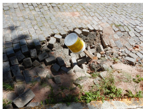
Foto 12 - Início de piping , meio fio solto e rua colapsando no morro dos Milionários.
