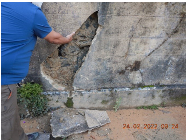
Foto 9 - Antigo muro de pedra pos trás do reboco
