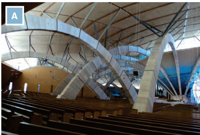
Figura 6.6 A e B: Santuário de Padre Pio, San Giovanni Rotondo, Itália, 2004. Uso de rochas como estrutura – elemento protagonista da composição da obra em arcos que também sustentam a cobertura, montados com blocos de rocha calcária e cabos de aço. Arquiteto Renzo Piano, Itália. Fotos Risale Neves (2011).
