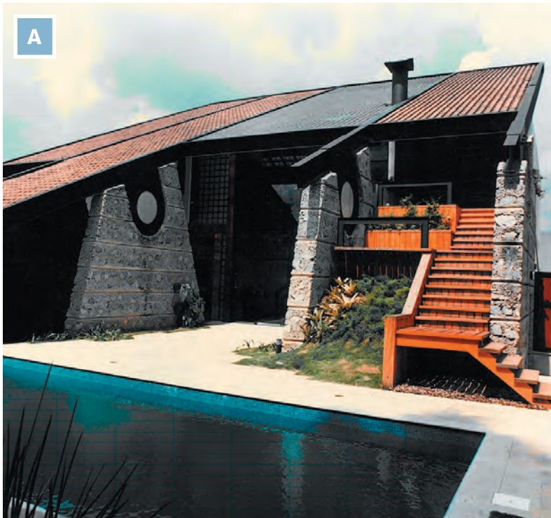
Figura 6.12 A e B: A) Residência em São Paulo, década de 1960. Vista geral de paredes/pilares em concreto ciclópico, formando o apoio da cobertura. B) Detalhes da estrutura. Arquiteto Carlos Bratke, São Paulo. Fotos cedidas pelo autor da obra (2010).
