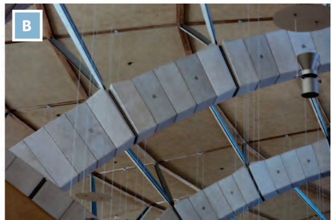
Figura 6.6 A e B: Santuário de Padre Pio, San Giovanni Rotondo, Itália, 2004. Uso de rochas como estrutura – elemento protagonista da composição da obra em arcos que também sustentam a cobertura, montados com blocos de rocha calcária e cabos de aço. Arquiteto Renzo Piano, Itália. Fotos Risale Neves (2011).
