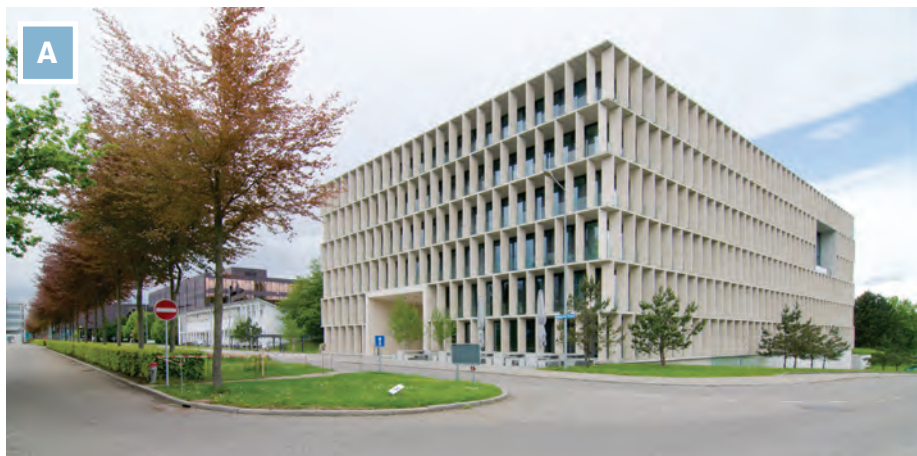
Figura 6.7 A e B: e-Science LAB do Instituto Federal Suíço de Tecnologia, Zurich, Composição com brises em placas de rochas para sombrear fachadas e detalhes. Fotos: A) Hans Jan Dürr ( www.flickr.com/photos/durr-architect/sets/ ). B) Eduard Hueber, archphoto © Baumschlager Eberle Architekten.
