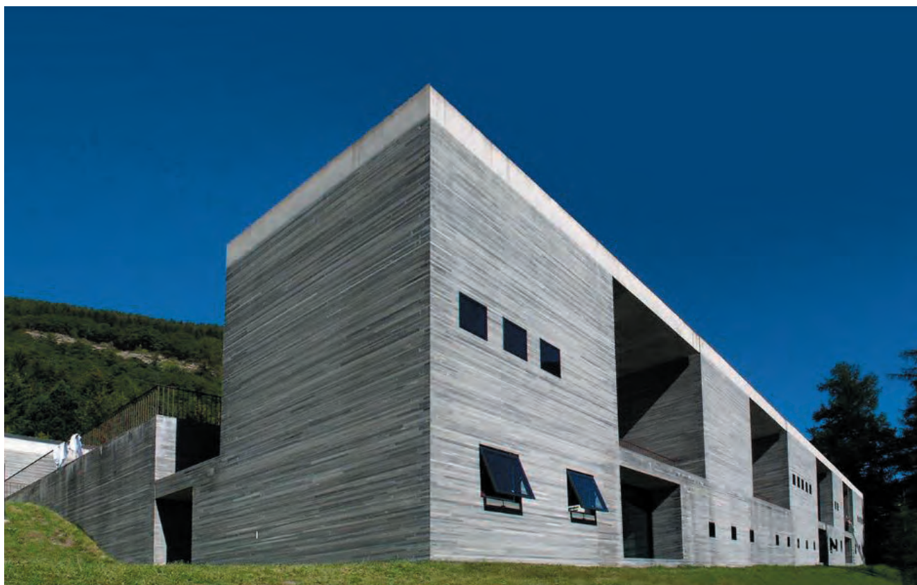
Figura 6.15: Termas de Vals, Suíça, 1996. Filetado regular (tiras serradas e niveladas em todo o revestimento externo e interno da obra – Prêmio Pritzker 2009. Arquiteto Peter Zumthor, Suíça. Foto Pablo Echávarri.
