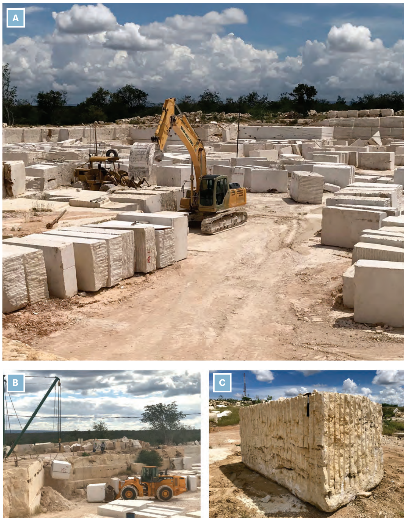
Figura 5.2 – Extração de rochas ornamentais tipo Bege Bahia, Ourolândia (BA). A) Frente de lavra. B) Frente de lavra mostrando a utilização de pau de carga e trator. C) Bloco esquadrejado e pronto para o transporte.
