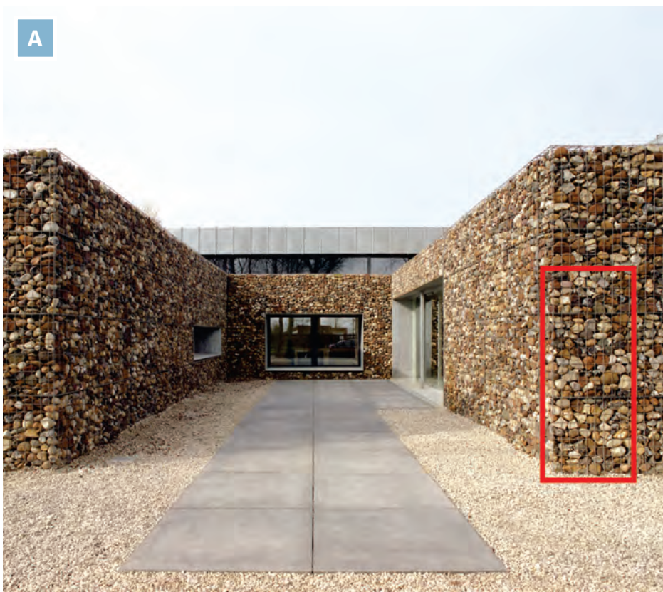
Figura 6.13 A e B: A) Artimo Textiles, Países Baixos. Paredes erguidas em gabião. B) detalhe. Projeto Oomen Architecten. Foto Frederik Vercruyse.
