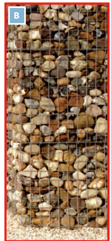
Figura 6.13 A e B: A) Artimo Textiles, Países Baixos. Paredes erguidas em gabião. B) detalhe. Projeto Oomen Architecten. Foto Frederik Vercruyse.
