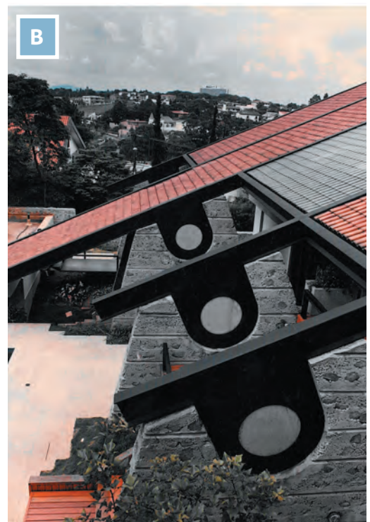
Figura 6.12 A e B: A) Residência em São Paulo, década de 1960. Vista geral de paredes/pilares em concreto ciclópico, formando o apoio da cobertura. B) Detalhes da estrutura. Arquiteto Carlos Bratke, São Paulo. Fotos cedidas pelo autor da obra (2010).
