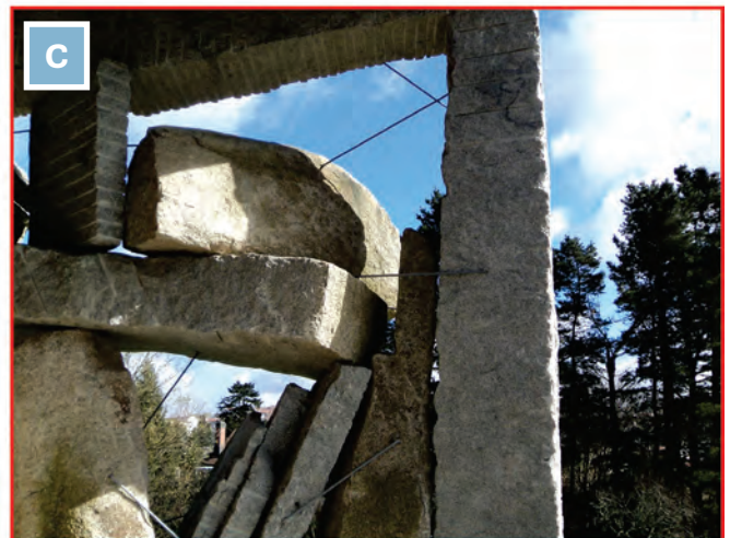
Figuras 6.10 A, B e C: A) Sede Geral de Autores Editores, SGAE, Santiago de Compostela, Espanha, 2002. Composição de fachada erguida com sobras de pedreira. B) Detalhe da parte esquerda da fachada. C) Detalhe interno. Arquiteto Antón García Abril. Espanha. Fotos Risale Neves (2011).
