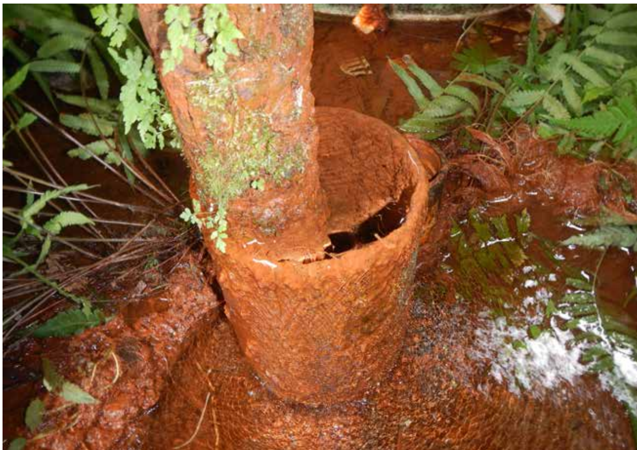
Figura 4.22. Ferro coloidal impregnando ao revestimento do poço JAP051 da antiga Cervejaria Antártica.
