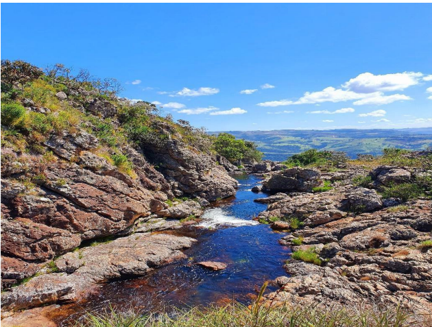
Figura 86 - Porção da Cachoeira Rolinhos, onde sugere-se impedir o acesso, visto que existe a possibilidade de movimentação de bloco rochoso, e os demais poços para banho atendem a atividade turística, com baixo perigo de queda de blocos. Fonte: Foto dos autores.
