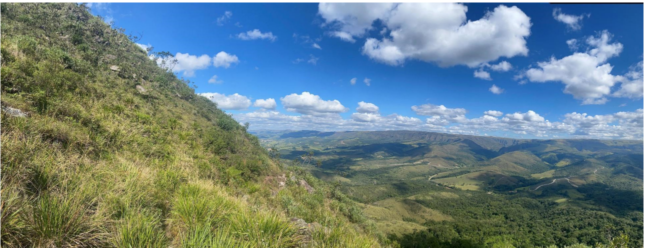
Figura 31 - Vista da Trilha Difícil, na porção onde há blocos soltos na encosta de alta declividade, com possibilidade de se movimentarem. Fonte: Foto dos autores.
