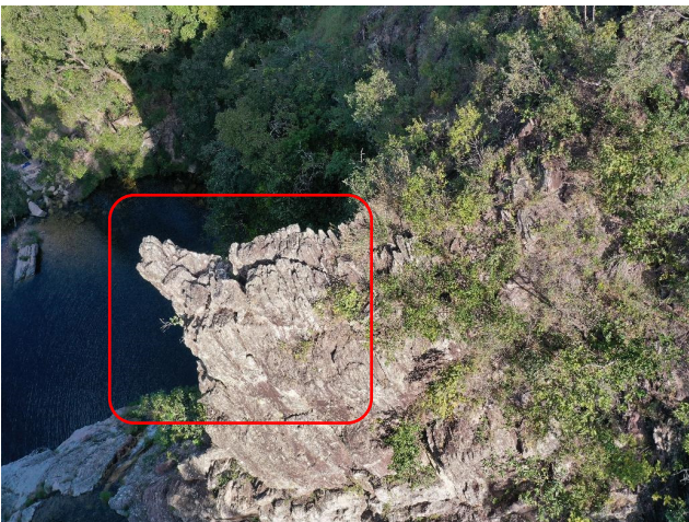
Figura 46 - Vista do drone, da porção proeminente, que apresenta perigo de queda de blocos. Fonte: Foto dos autores.
