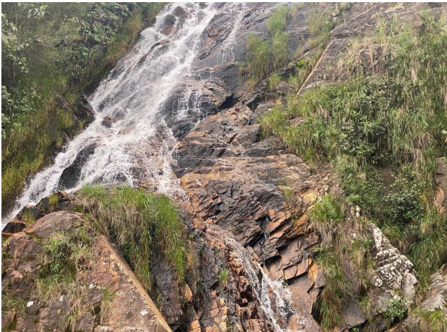
Figura 50 - As discontinuidades presentes no maciço rochoso (fraturas e foliação) delimitam blocos, predominantemente centimétricos, que se movem ao longo do paredão, e atingem as proximidades da queda d'água, no poço para banho. Fonte: Foto dos autores.
