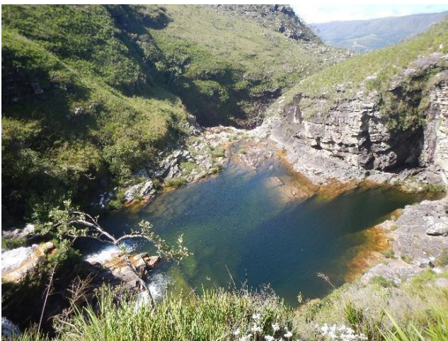
Figura 19 - Vista do Poço Fundo, local com perigo de atingimento do processo de queda e tombamento do bloco rochoso. Fonte: Foto dos autores.
