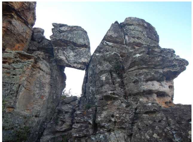
Figura 69 - Bloco rochoso com perigo de queda, em meio aos blocos ruiforme. Fonte: Foto dos autores.
