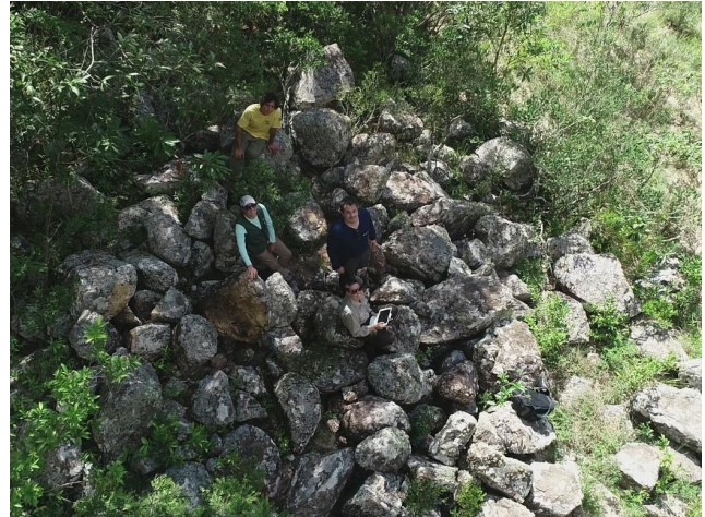
Figura 41 - Blocos rochosos de dimensões métricas, localizados após o poço para banho da cachoeira do Fundão, caracterizando toda a área com potencial de ser atingida pelos blocos que se desprendem do paredão rochoso. Fonte: Foto dos autores.
