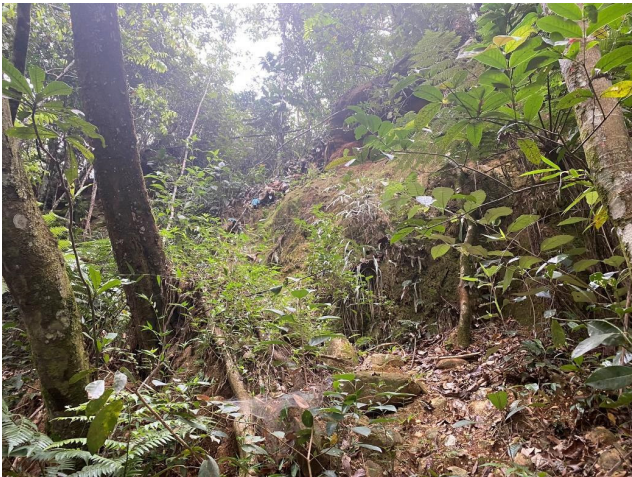
Figura 34 - Porção da encosta onde ocorreu o deslizamento de solo, que atingiu parcialmente a Trilha Saint-Hilaire. Nota-se a presença de lixo enterrado, que potencializa o processo, da antiga ocupação humana da região. Fonte: Foto dos autores.
