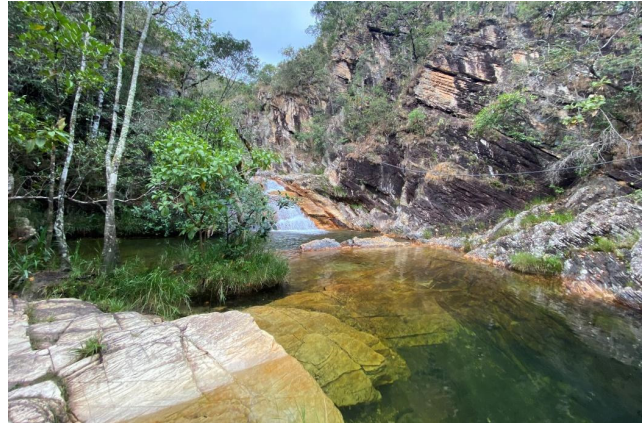
Figura 75 - Vista da cachoeira Sofazinho. Há menor perigo de queda de blocos rochosos devido ao confinamento das descontinuidades, o que dificulta a livre movimentação dos blocos eventualmente formados. Fonte: Foto dos autores.
