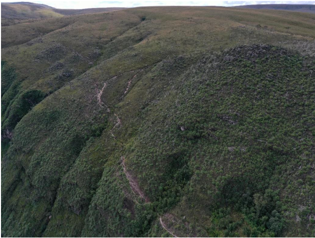
Figura 29 - Vista aérea do drone da porção da Trilha Difícil, onde ela percorre a meia encosta de alta declividade, a qual apresenta blocos rochosos com potencial de se movimentarem. Fonte: Foto dos autores.
