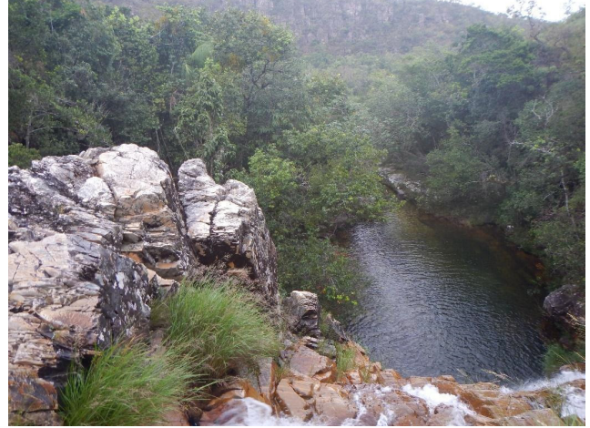
Figura 57 - Detalhe de bloco rochoso com grande potencial de queda do topo da cachoeira das Borboletas, atingindo o poço para banho, com alto dano associado. Fonte: Foto dos autores.
