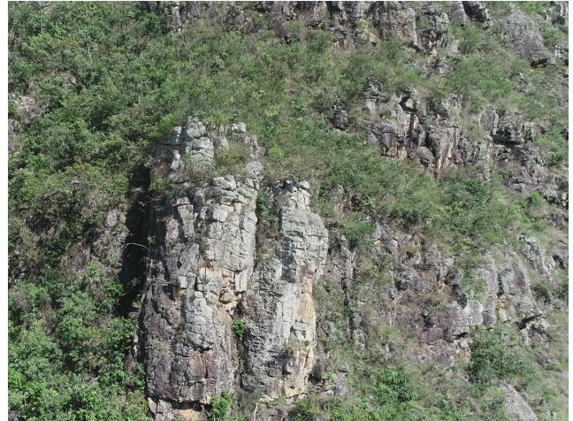
Figura 37 - Detalhe do paredão rochoso que circunda o poço da cachoeira do Fundão, visto do drone, com blocos rochosos delimitados, na iminência de queda. Em função da altura e dimensão dos blocos, trata-se de um evento potencial com alto dano associado. Fonte: Foto dos autores.
