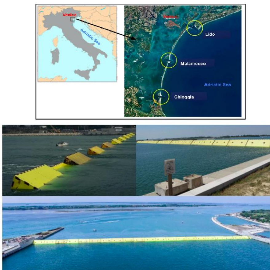
Figura 4 - Sistema de barreiras construído para evitar o alagamento da cidade de Veneza durante as cheias de maré muito intensas.
