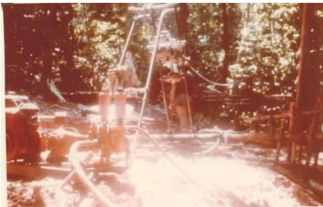
**Figura 7** - Sonda Winkie GW-15 instalada e preparada para início de perfuração. Fonte: Companhia de Pesquisa de Recursos Minerais (1979a, 1979b).
