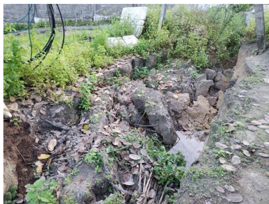
Figura 8 - Movimentação do solo com afastamento de 1,5 metros. Setor 4.
