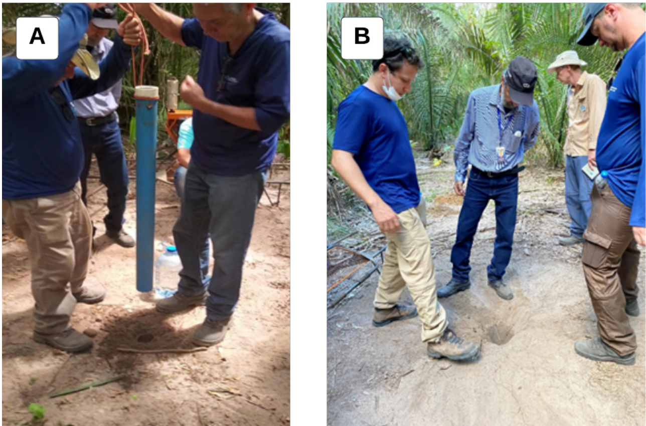
Figura 07 - Finalização do trabalho de sondagem para ensaio de infiltração: A) retirada dos tubos, B) fechamento dos furos com terra. Fonte: os autores.
