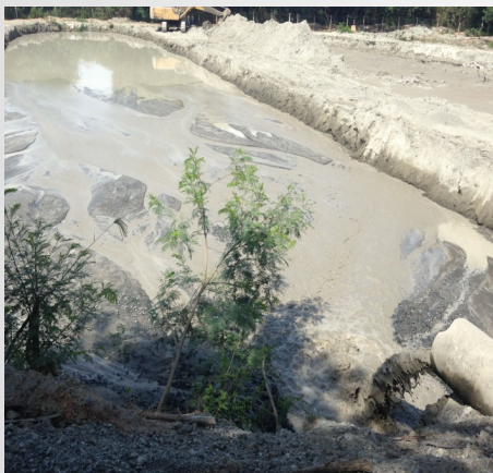
Direcionamento de águas de lavagem de pilhas de brita (2018)
