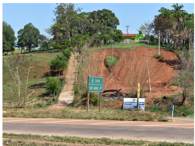
Figura 4.37: Exposição de talude, na unidade DSVMPsaa. Foto: Rodrigo Luiz Gallo Fernandes (2022).
