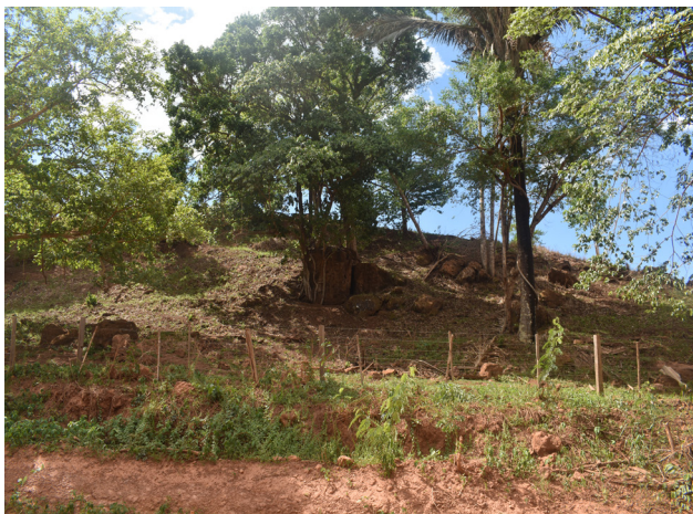
Figura 4.8: Rampa de colúvio/tálus. Foto: Rodrigo Luiz Gallo Fernandes (2022).
