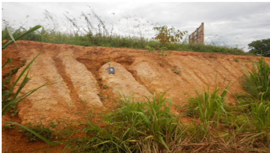
Figura 3.13: Talude na margem da Rodovia BR 364, sedimentos constituídos de folhelhos síltico-arenosos e arenitos finos subordinados, finamente, amarelados a avermelhados, pertencentes à Formação Ponta Grossa. Foto: José Antônio da Silva (2022).
