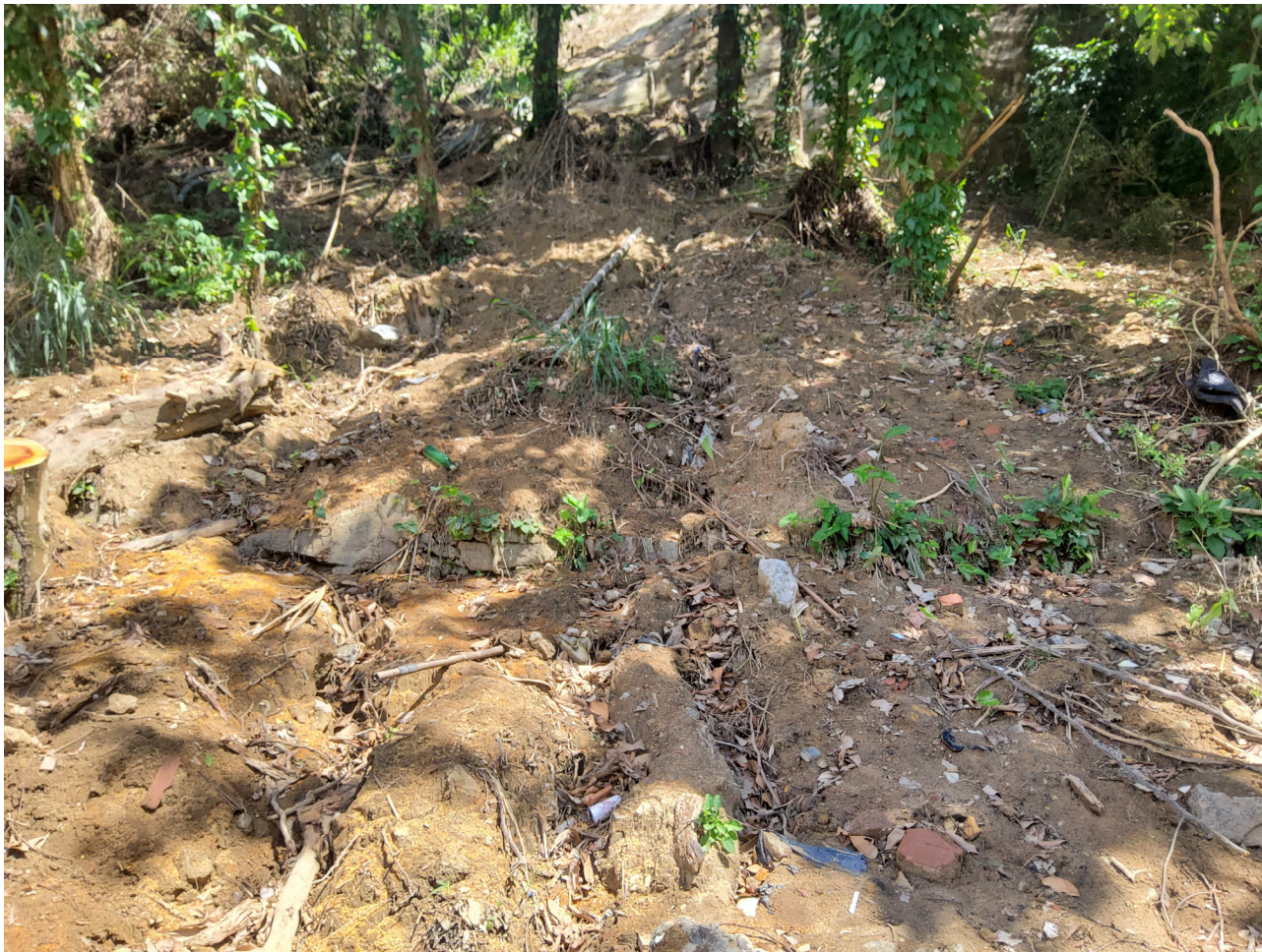
Figura 5 - Material heterogêneo mobilizado no deslizamento
