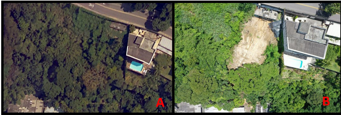
Figura 2 - A- Imagem da encosta antes do deslizamento. Fonte: Google Earth. B - Imagem obtida com o Drone Mavic após o deslizamento.
