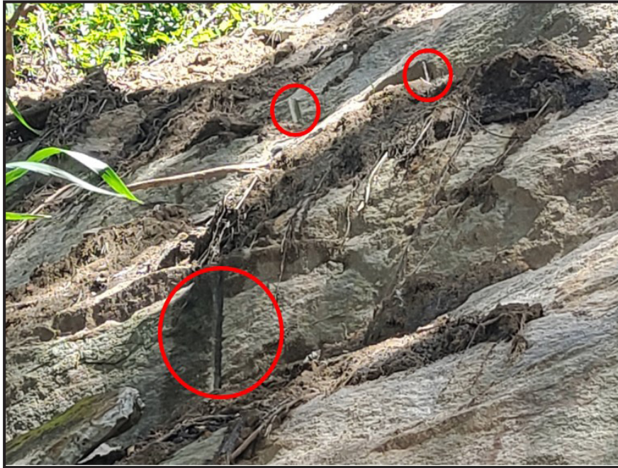
Figura 9 - Marcas de perfuração para colocação de explosivos.
