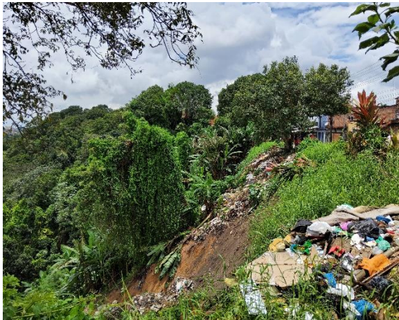
Figura 5.5a. Topo da encosta. Aterro com lixo/bota fora depositado na voçoroca. Rua Angelim.
