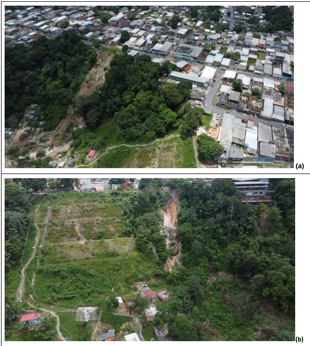
Figura 5.8. Área atingida pelo deslizamento e corrida de lama e detritos (a). Voçoroca em evolução na rua 3 (b).
