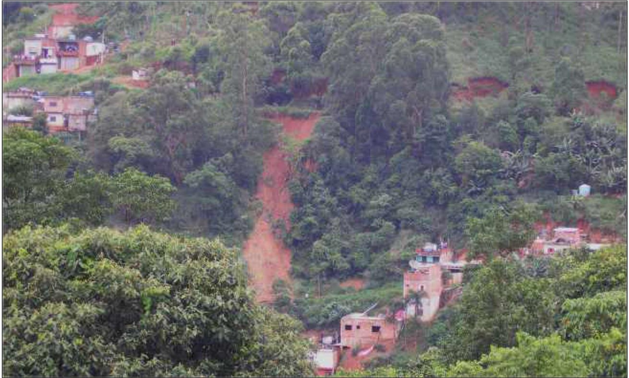
Figura 6 – Cicatriz de escorregamento translacional, condicionado por ação antrópica de desmatamento, cortes e aterros, induzindo a concentração de água em superfície, no topo da cicatriz. Bairro Itaberaba II, Distrito Anhanguera, São Paulo, SP. Fonte: Santos (2020).
