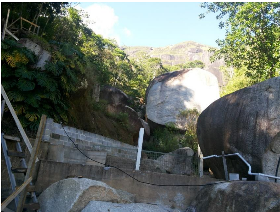
Figura 8 – Exemplo de rolamento de blocos em Nova Friburgo – RJ. Fonte: Antonelli (2018).
