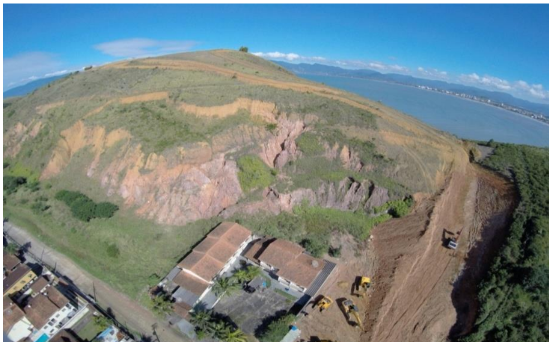
Figura 4 – Escorregamento rotacional em Caraguatuba – SP. Fonte: Antonelli (2018).
