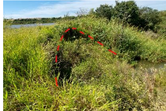
Figura 4. Cicatriz de deslizamento com processo erosivo instalado no talude da barragem.
