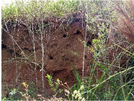
Figura 3. Erosão interna (“piping”) no talude da barragem.
