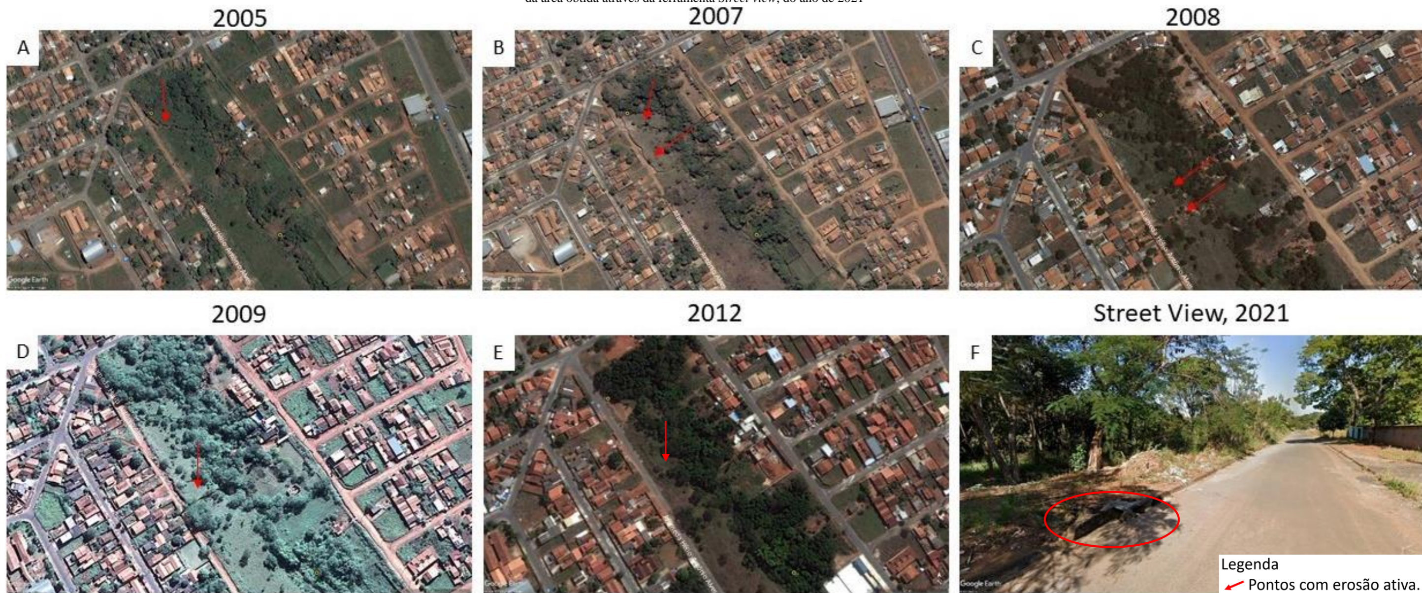
Figura 23 - Análise da evolução temporal da feição erosiva 18, cadastrada por Ferreira de Oliveira (2005). A) Feição erosiva em 2005; B) Feição erosiva em 2007; C) Feição erosiva em 2008; D) Feição erosiva em 2009; E) Feição erosiva em 2012; F) Imagem da área obtida através da ferramenta Street view , do ano de 2021
