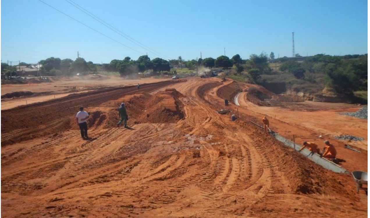
Figura 6 - Obras de estabilização com aplicação na prevenção e controle de erosão
