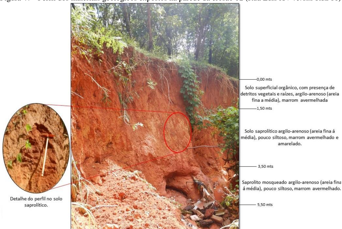
Figura 47 - Perfil dos materiais geológicos expostos na parede da erosão 02 (Rua Luís XV versus Rua 10)
