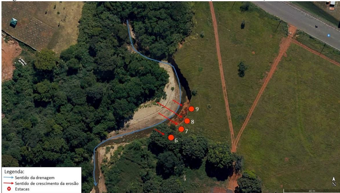
Figura 39 - Posicionamento das estacas instaladas na erosão 01 (Avenida Toledo) em fevereiro de 2022
