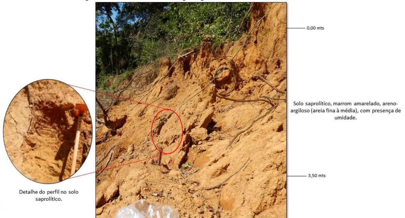
Figura 53 - Perfil dos materiais geológicos associados à erosão 08
