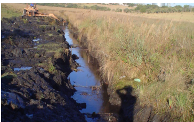
Figura 48 - Abertura de um canal de drenagem em meio a uma região pantanosa com depósitos de turfa. Fonte: Mineração Varginha, 2017.
