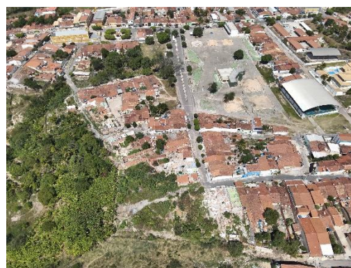
Figura 3 – Casas destruídas no distrito de Jamacaru.
