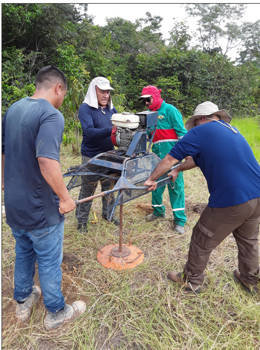
Figura 5 - Execução do FT-02, na área 2. Foto: acervo dos autores.
