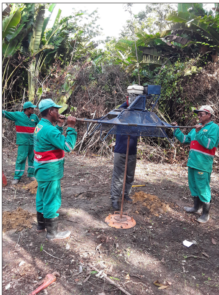
Figura 4 - Execução do FT-01. Foto: acervo dos autores.
