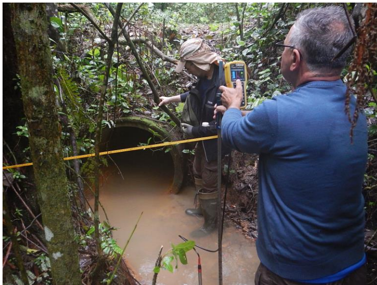
Medição de vazão sendo realizada no ponto BM 022
