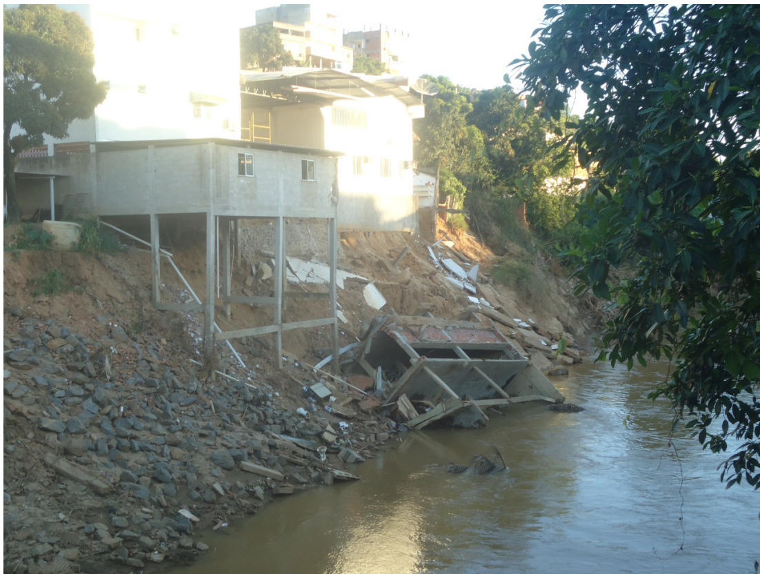
Figura 70 - Residências destruídas as margens do rio Santa Maria com a passagem da cheia do dia 24-12-2013 Local: Alto Vila Nova
