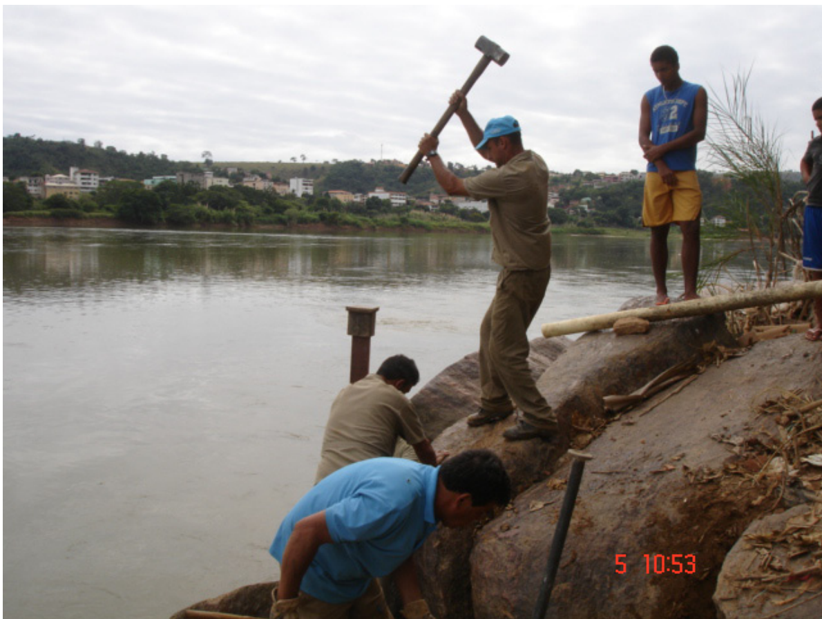
Figura 47 - Implantação da seção de réguas (realizado em 2009) Local: Bairro Colatina Velha (seção 300)
