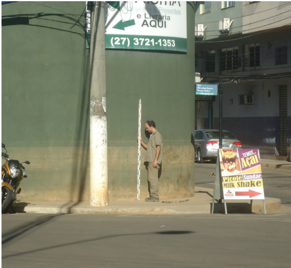
Figura 66 - Levantamento das marcas de cheia da enchente do dia 24-12-2013 Local: Bairro Centro
