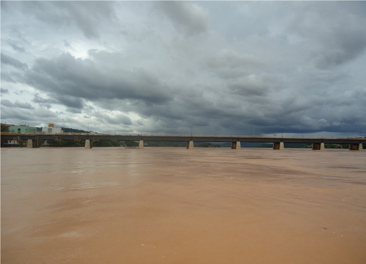
Figura 56 - Seção de medição de vazões no rio Doce com vista para montante Local: Bairro Centro (seção 800)
