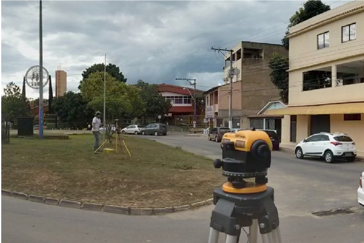
Figura 68 - Uso de receptor gps e mira para levantamento topográfico Local: Bairro Centro
