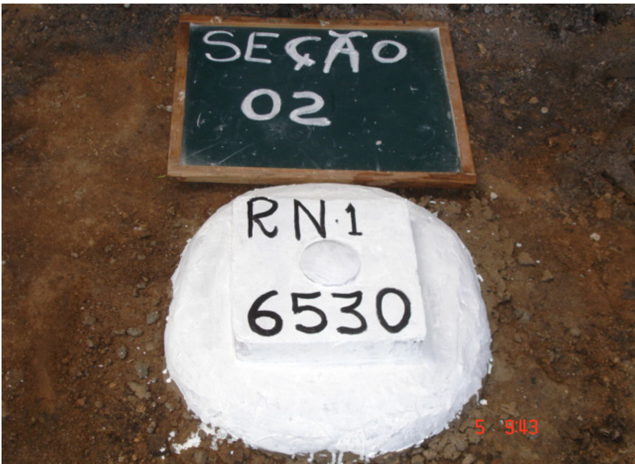
Figura 49 - Construção de referência de nível (realizado em 2009) Local: Bairro Colatina Velha (seção 200)
