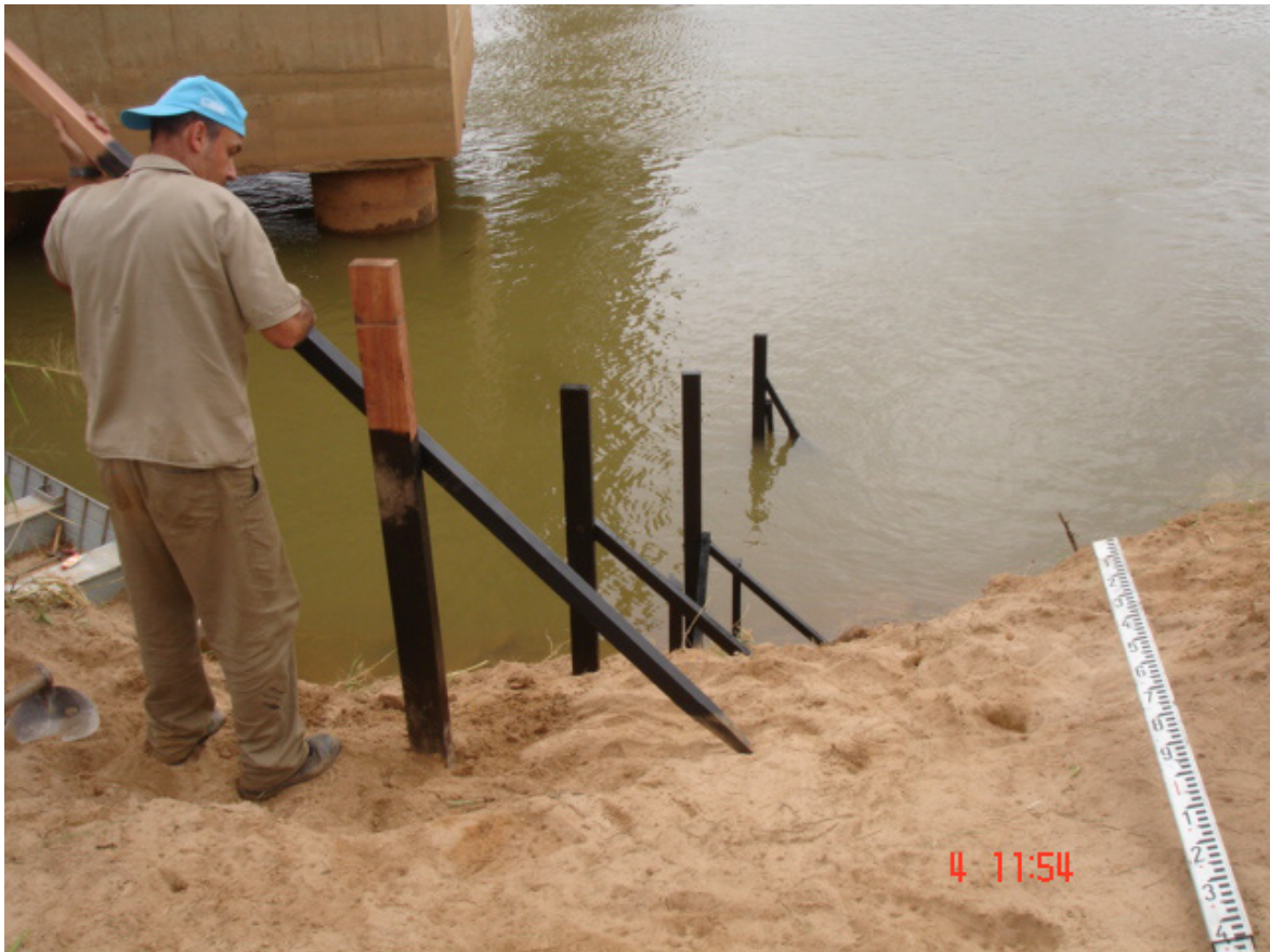
Figura 46 - Implantação da seção de réguas próxima a ponte Sérgio Ceotto (realizado em 2009) Local: Bairro Colatina Velha (seção 100)
