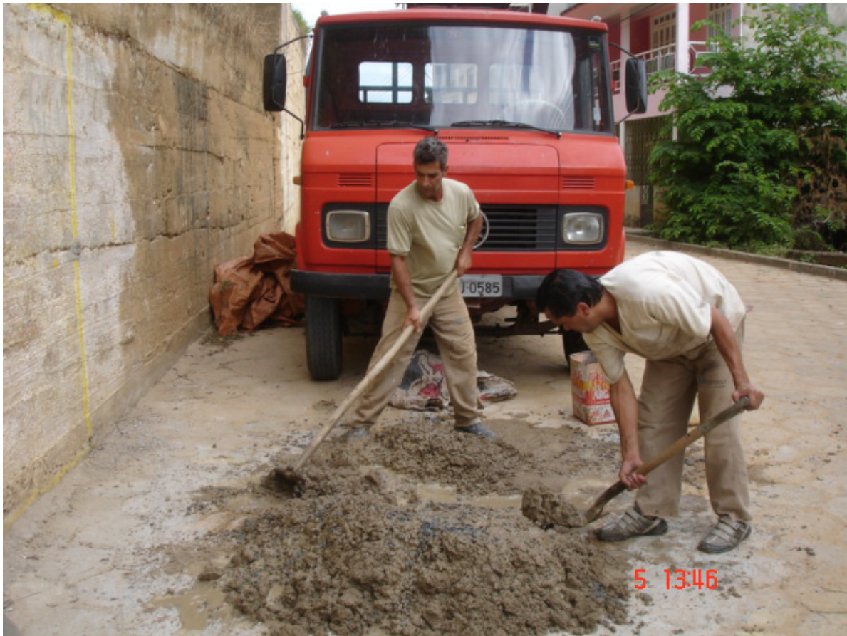
Figura 48 - Preparação de concreto para construção das Rrnn (realizado Em 2009) Local: Bairro Colatina Velha (seção 300)
