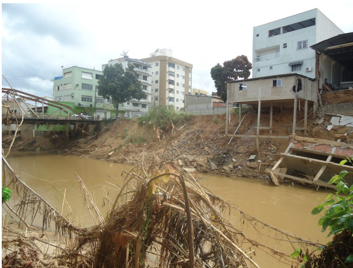
Figura 71 - Residências destruídas as margens do rio Santa Maria com a passagem da cheia do dia 24-12-2013 Local: Alto Vila Nova
