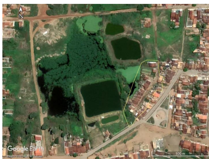
Figura 3 – Área atingida pelos alagamentos indicado em amarelo. Notar lagoa no centro.
