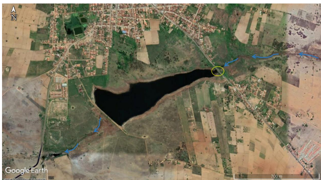
Figura 6 – Imagem aérea do açúde. Em amarelo, trecho da AL-486 em que a água impossibilita a passagem em períodos chuvosos. Em azul o sentido do fluxo.
