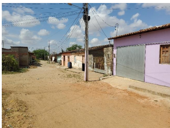
Figura 4 – Imóveis atingidos pelos alagamentos.
