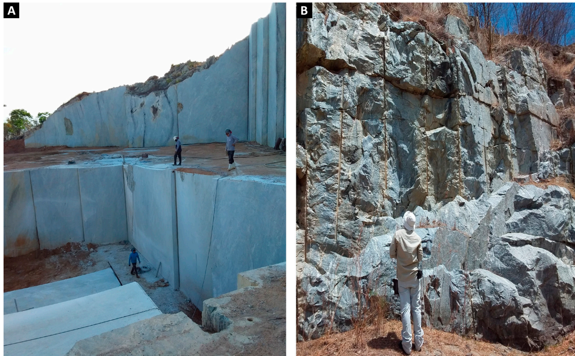
Figura 8.6 - A) Extração ativa de rocha ornamental em encosta de morro, expondo cortes horizontalizados e verticalizados feitos por fio diamantado em lavra do Quartzito Cielo, Thorgranitos (AF084); B) aspecto da frente de lavra de extração de brita utilizando explosivos (AF060). Fonte: arquivo do projeto.
