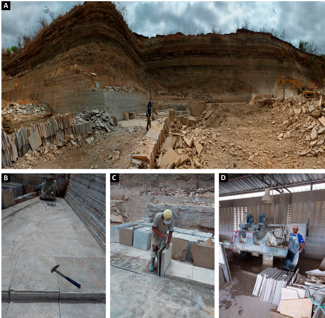
Figura 6.26 - A) Frente de lavra da Pedra Cariri (IB90); B) Retirada de placas com máquina elétrica de corte; C) Desdobramento manual em lamínas; D) Beneficiamento das chapas por desbaste. Fonte: arquivo de campo do projeto.
