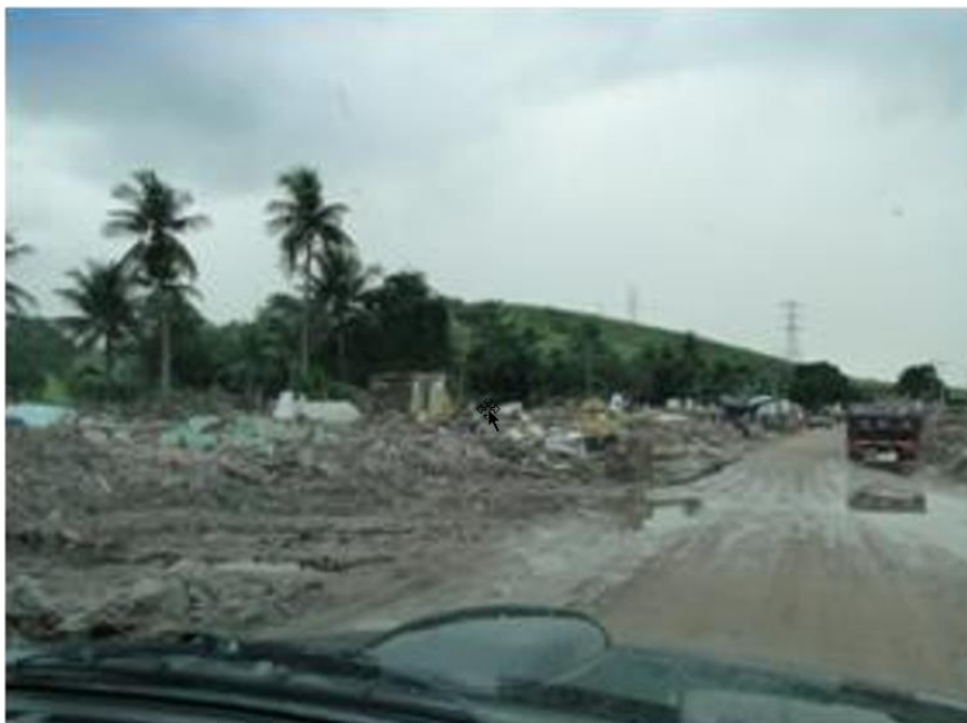
Figura 2.5 – Destruição total das casas na margem esquerda do rio Mundaú em União dos Palmares na cheia de 2010. Fonte: CPRM, 2010.
