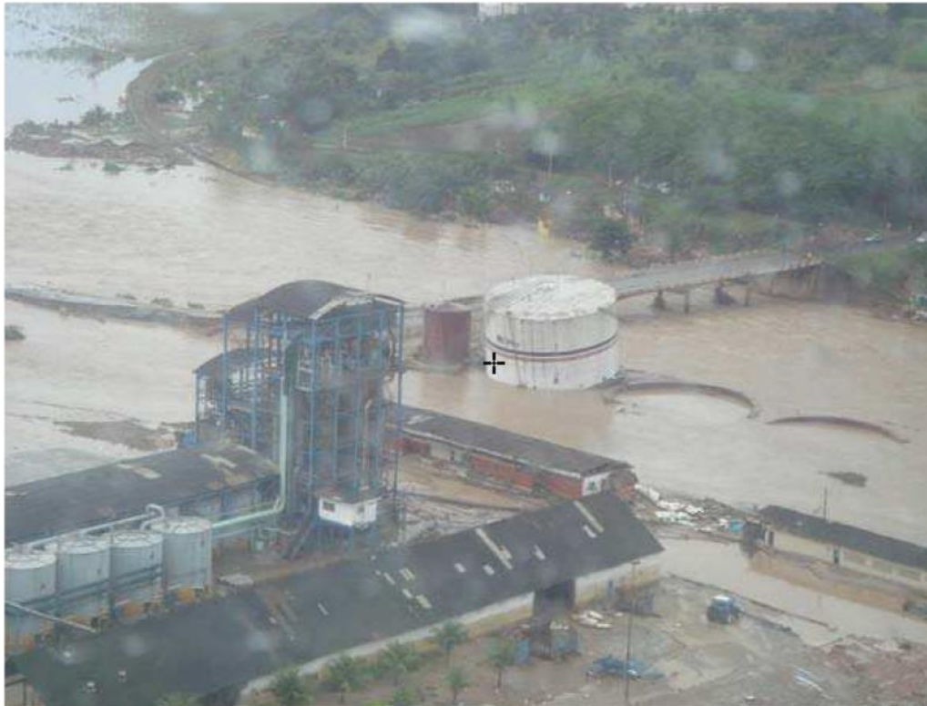
Figura 2.2 – Inundação da Usina Laginha com enorme tanque de álcool em União dos Palmares, junho de 2010 no rio Mundaú. Fonte: CPRM, 2010.
