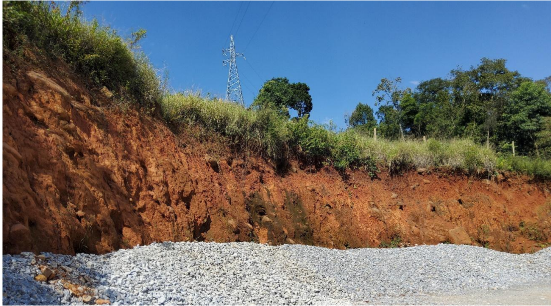
Figura 31: Ponto de campo número 21 - Depósito de tálus com blocos de matacões expostos. Coordenadas UTME: 670509 UTMN: 7211759 - Rio Branco do Sul – PR.
