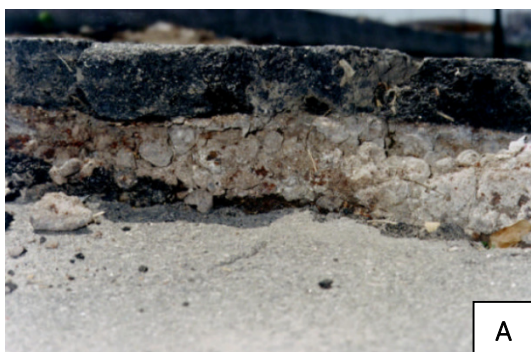
Figura 2 – A) Pavimento rompido: expansão da escória utilizada na construção de rodovia no ES. Fonte: Baltazar (2001). B) Deformações pela expansão da escória utilizada em pavimento. Fonte: Raposo (2005).
