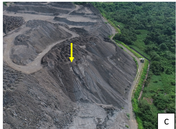
Figura 11 – Feições em talude voltado para o Rio Paraíba do Sul. A) Mapa de feições de instabilidade #3: taludes voltados ao Rio Paraíba do Sul. B) Vista aérea por RPA: movimento translacional raso associado a feições erosivas. C) Vista aérea por RPA: destaque (seta amarela) das feições erosivas e do deslizamento translacional raso na interface de um corte no terço inferior do talude.
