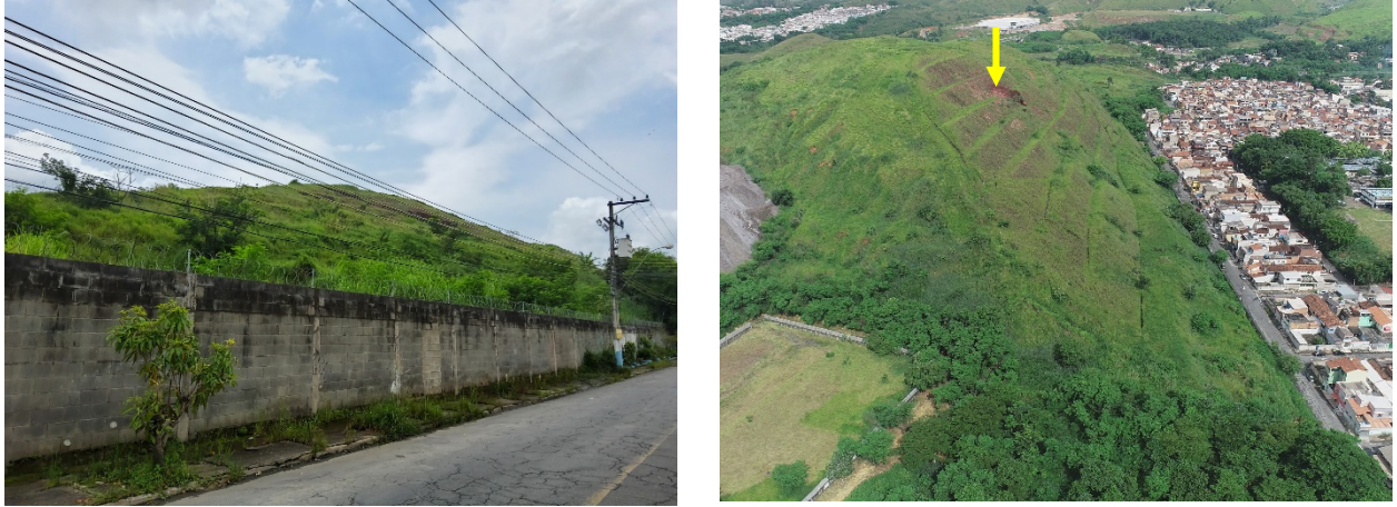
Figura 15 – A) Vista do chão do morrote localizado no interior da propriedade da Harsco Metals LTDA. B) Cicatriz de deslizamento identificada em imagem aérea obtida por RPA
