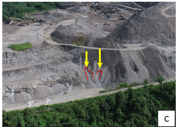
Figura 10 – Feições em talude voltado para o Rio Paraíba do Sul. A) Mapa de feições de instabilidade #2: taludes voltados ao Rio Paraíba do Sul. B) Vista do chão: movimentos rasos com acumulações lindeiras ao sopé do talude de escória. C) Vista aérea por RPA: destaque (seta amarela) dos deslizamentos translacionais rasos na interface da intervenção por bermas com talude.
