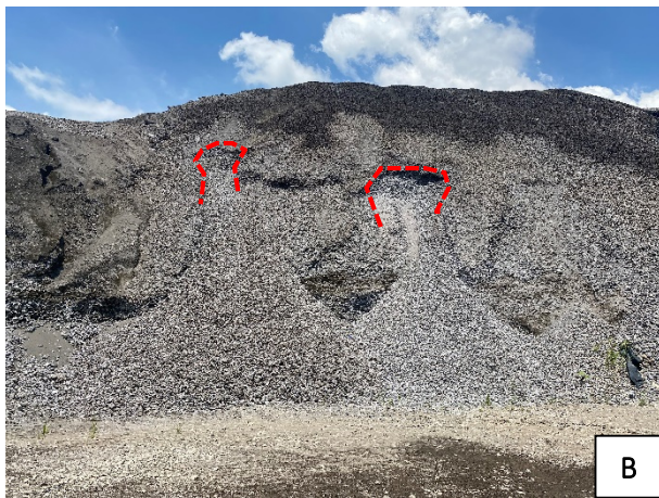
Figura 10 – Feições em talude voltado para o Rio Paraíba do Sul. A) Mapa de feições de instabilidade #2: taludes voltados ao Rio Paraíba do Sul. B) Vista do chão: movimentos rasos com acumulações lindeiras ao sopé do talude de escória. C) Vista aérea por RPA: destaque (seta amarela) dos deslizamentos translacionais rasos na interface da intervenção por bermas com talude.
