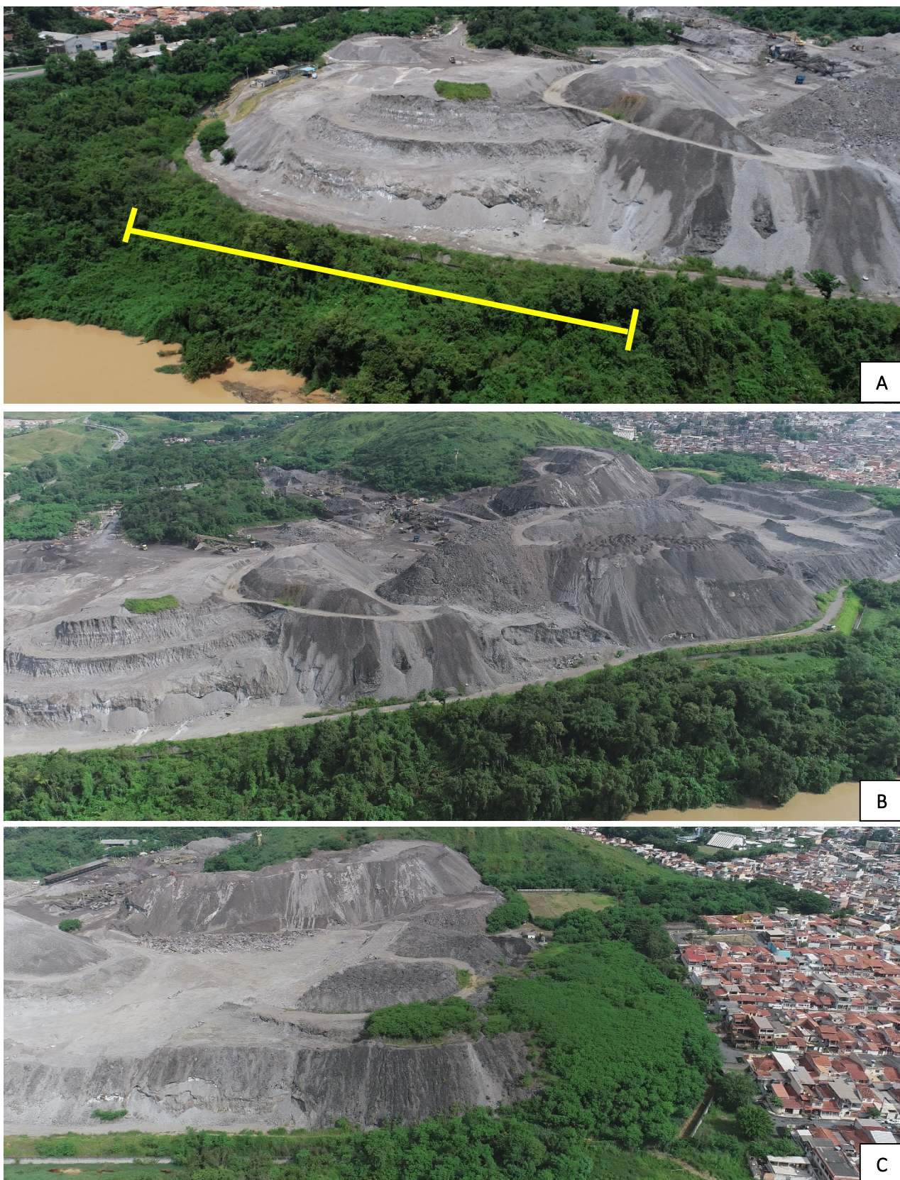
Figura 6 – A) Fotografia aérea oblíqua tomada por RPA da porção da pilha de escória siderúrgica que se localiza mais próxima da margem direita do Rio Paraíba do Sul. Observar o escalonamento em bermas realizado no trecho destacado. B) Trecho intermediário dos taludes voltados ao Rio Paraíba do Sul: maior amplitude identificada (~40,0m). C) Trecho nas proximidades do bairro Volta Grande de menor amplitude.
