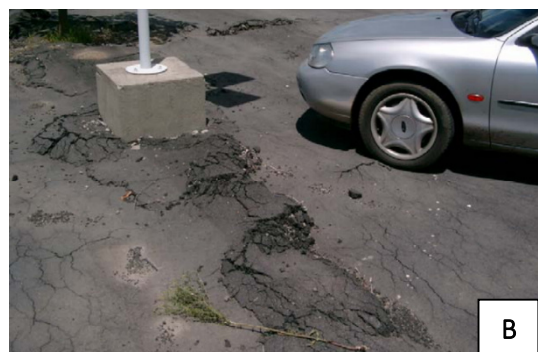
Figura 2 – A) Pavimento rompido: expansão da escória utilizada na construção de rodovia no ES. Fonte: Baltazar (2001). B) Deformações pela expansão da escória utilizada em pavimento. Fonte: Raposo (2005).
