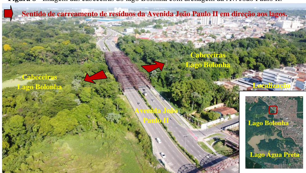
Figura 8 - Imagem das cabeceiras do lago Bolonha com drenagem da Av. João Paulo II.
