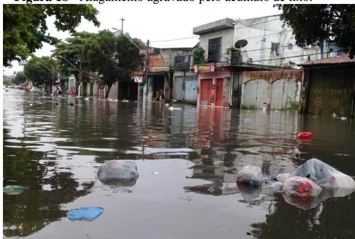
Figura 18 - Alagamento agravado pelo acúmulo de lixo.
