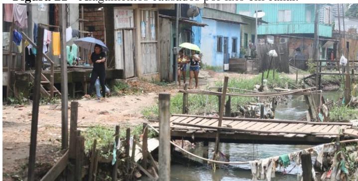
Figura 21 - Alagamentos causados por lixo em canal.
