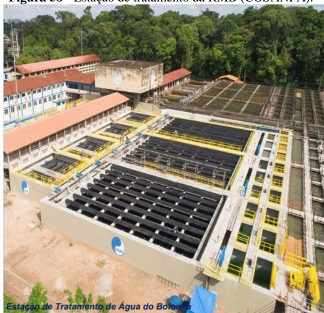
Figura 58 - Estação de tratamento da RMB (COSANPA).
