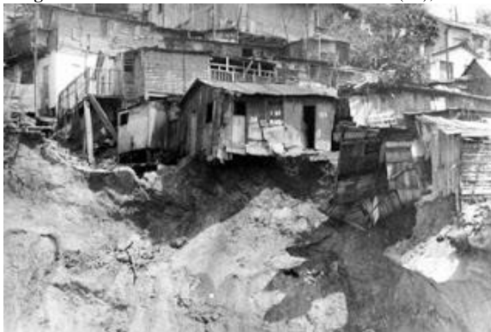
Figura 12 - Morro da Providência – Rio de Janeiro (RJ), 1910.
