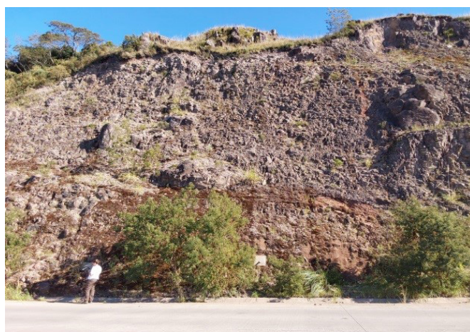
FIGURA 20 - Contato entre dois derrames ácidos da Fm. Palmas. O derrame inferior apresenta vesículas estiradas e a base do derrame superior apresenta disjunções em lajes, na Estrada da Rocinha, cota 1.200 m, em Timbé do Sul, SC. Autor: Melissa Franzen (2023).
