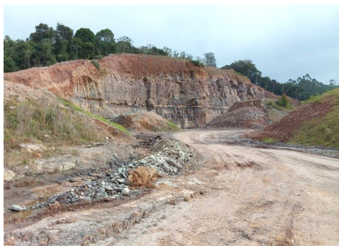
FIGURA 33 - Extração de argila refratária licenciada da Fm. Teresina na estrada para Rio do Meio, em Morro Grande, SC. Autor: Melissa Franzen (2023).
