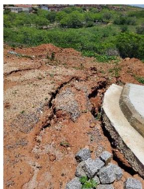
Figura 5 – Processo erosivo na rua, por falta de escoamento adequado (período de obra).
