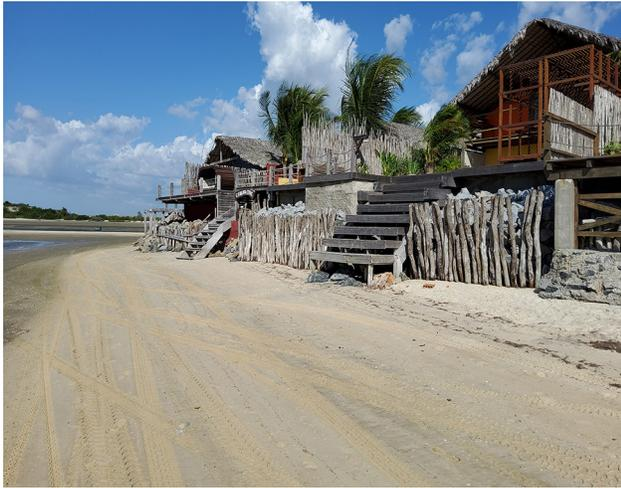
**Figura 4.15:** Contenção feita com enrocamento para mitigar os efeitos da erosão marinha na Praia da Tatajuba, em Camocim (CE). Fonte: Elaborado pelos autores.
