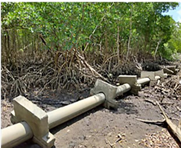
**Figura 4.8 d:** Baixa capacidade de suporte do solo de mangue gerando movimentação nas estruturas de suporte do duto.
