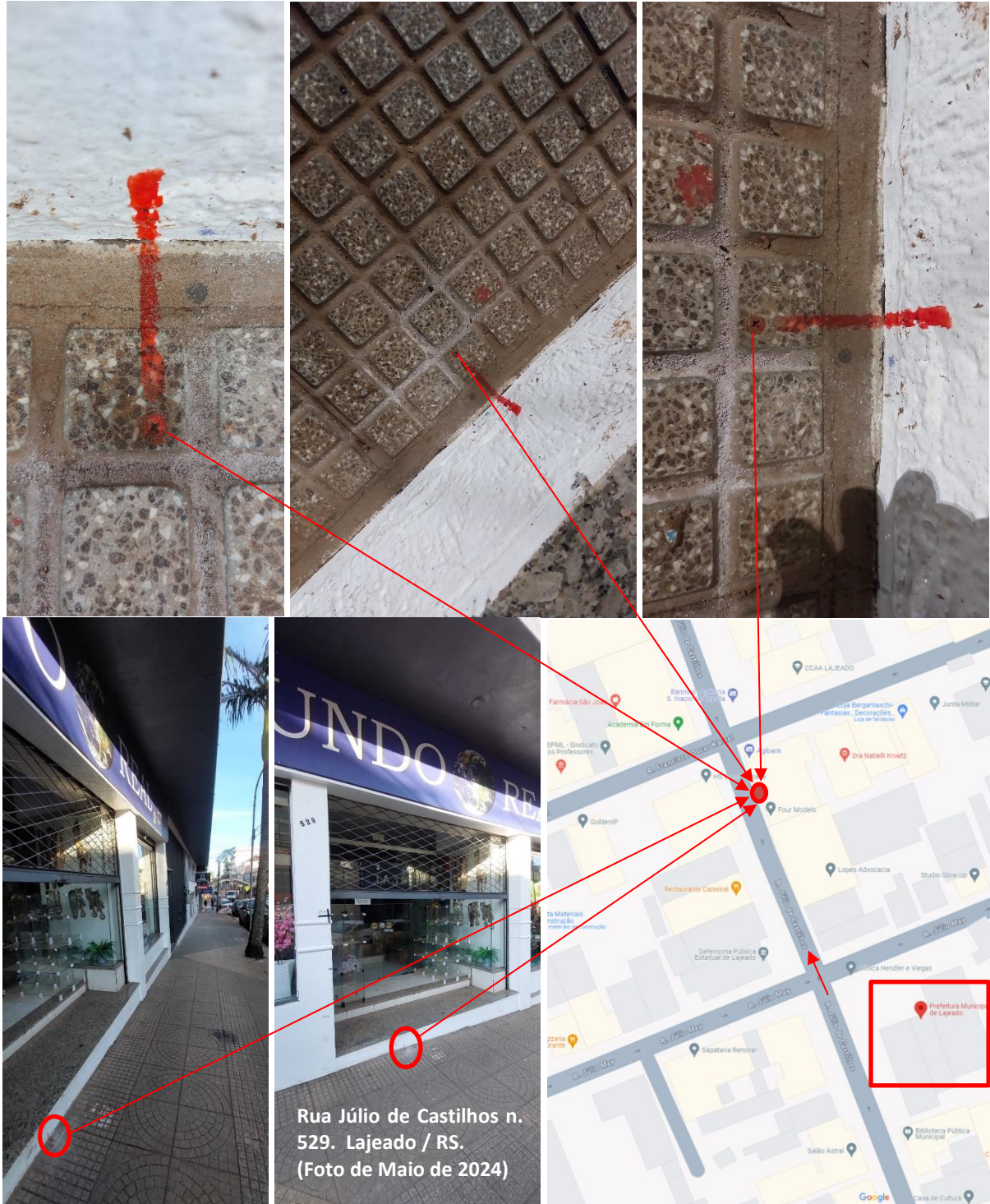
Figura 8. Fotos mostrando o parafuso da marca de cheia em Lajeado, quando o nível do rio Taquari atingiu seu nível máximo, em 02/05/2024, às 13h30min. O parafuso, colocado pela equipe do Serviço Geológico do Brasil, se encontra subindo a rua Júlio de Castilhos n. 529, após a prefeitura de Lajeado, na calçada da direita, antes de chegar na esquina com a rua Francisco Óscar Karnal. A Tabela 6 mostra as informações de coordenadas e demais dados deste ponto.
