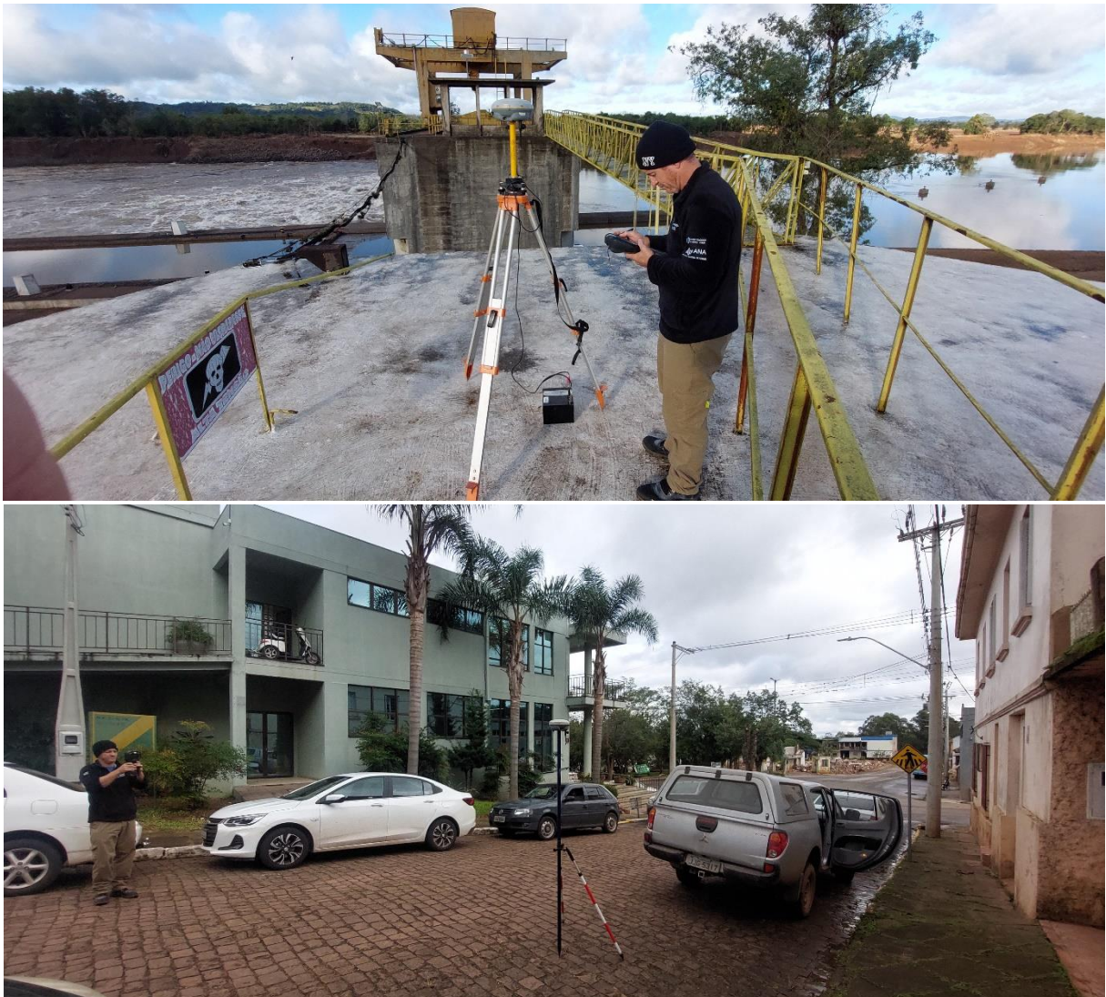
Figura 8. Base do rastreamento na eclusa de Bom Retiro do Sul / RS e rastreamento na cidade.
