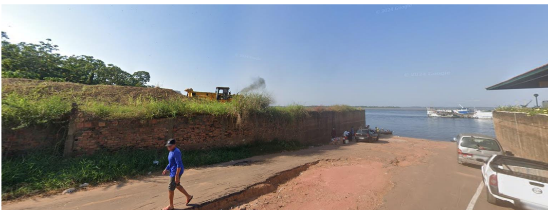
Figura 4 - Vista da rampa de acesso à praia mostrando, à esquerda, o barranco que deslizou. O barranco era contido por muro de tijolos e estacas e, próximo à praia, o muro era de concreto. Observa-se movimentação de material (aterro) com equipamento pesado. Fonte: Google Maps, julho de 2024.
