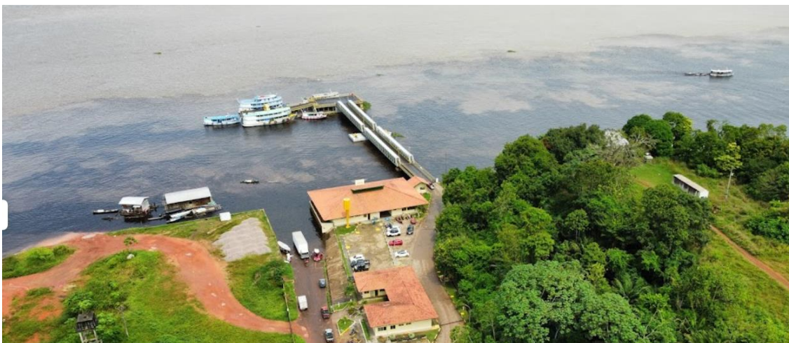
Figura 3 - Vista aérea do porto da Terra Preta mostrando a rampa, antes do evento e em período de cheia. À direita da rampa, encontra-se o terminal hidroviário e à esquerda, o barranco com talude vertical e a estrutura de contenção em formato de L. Foto Google Maps, julho de 2024.
