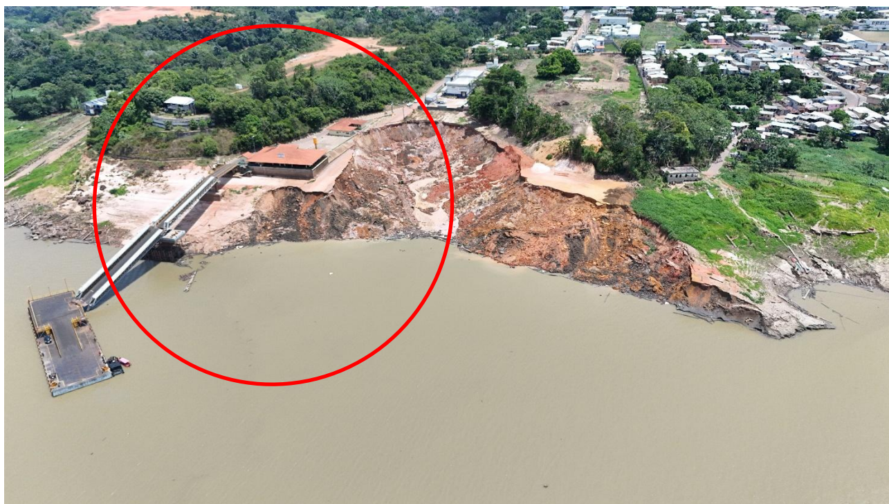
Figura 1 - Deslizamento de terra no Porto de Terra Preta, em Manacapuru-AM. Notar geometria semicircular da ruptura que se alarga nas proximidades da margem do rio Solimões. O terminal Hidroviário de Manacapuru (círculo vermelho) foi parcialmente afetado.
