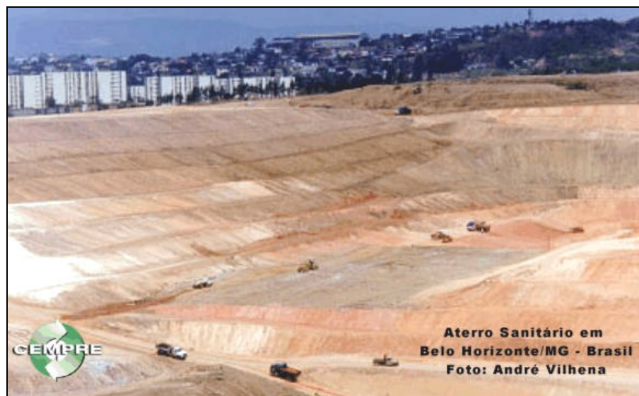
Figura 4.10. Aterro sanitário em Belo Horizonte.
