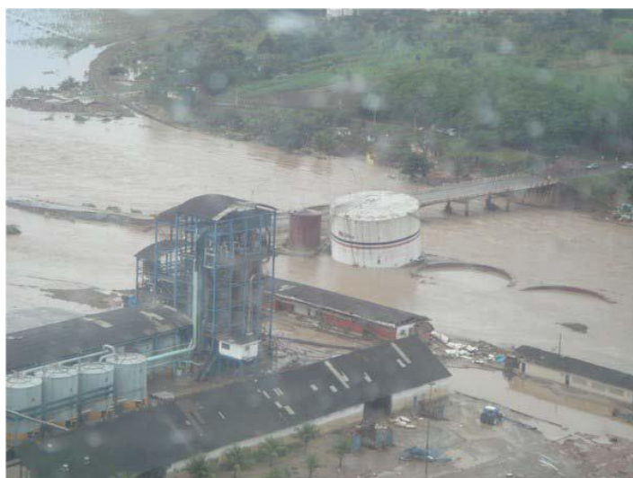
Figura 11 - Usina Laginha no município de União dos Palmares, durante a cheia de junho de 2010, no rio Mundaú. Destaque para o local onde funcionava o tanque de álcool. Fonte: SGB (2010).
