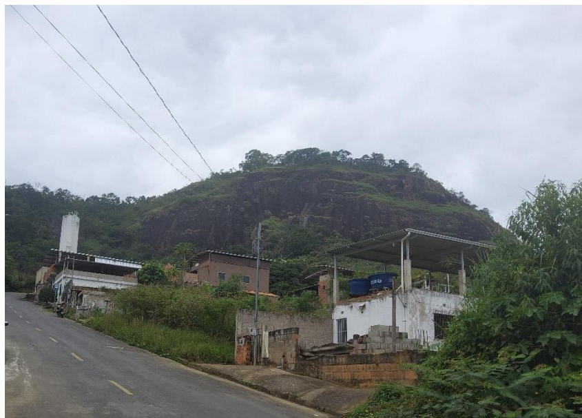
Figura 13 - Vista de afloramento representativo da unidade, próximo ao ponto 20.
