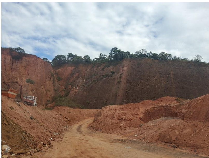
Figura 11 - Área utilizada como empréstimo de material, com exposição do horizonte solo residual estruturado, constituído por camadas silto-arenosas, friáveis e erodíveis.
