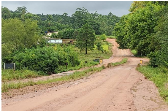
Figura 8 – Localidade mais baixa da estrada, duplicação e construção de uma segunda ponte ao lado da antiga, sobre o rio Pimenta.
