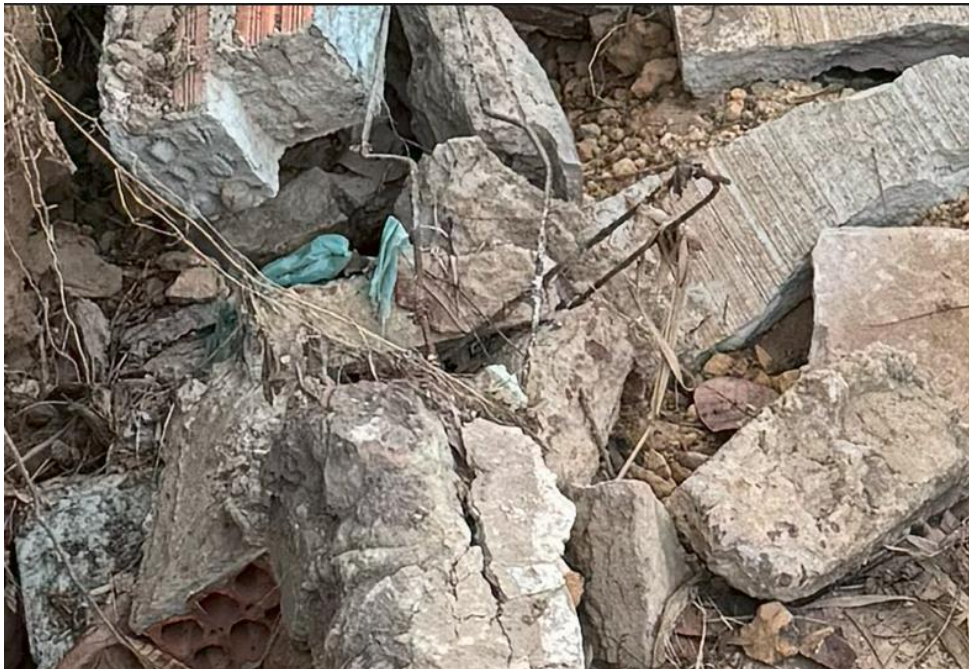
Foto 10 - Materiais inadequados e ferragens oxidadas por exposição ao ar.
