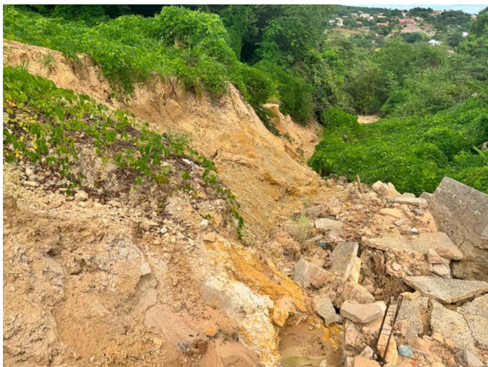
Foto 12 - Deslizamentos de pequenos portes.
