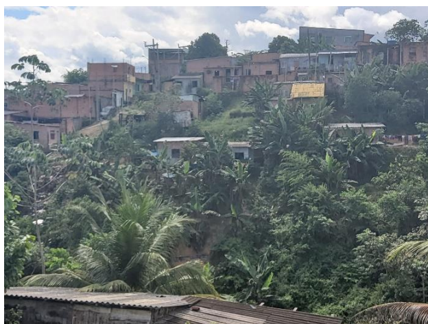
Figura 14- Vista de encosta parcialmente desmatada com ocupações irregulares, em corte e aterros, com cicatriz de deslizamento na base. (Autores)
