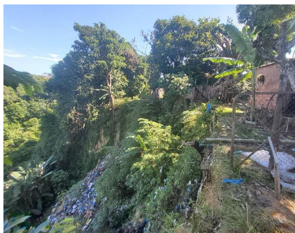
Figura 15- Lançamento de resíduos sólidos e águas pluviais e servida diretamente sobre o talude com cicatrizes de deslizamentos. (Autores)
