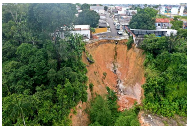
Figura 18- Voçoroca ocasionada pelo fluxo concentrado de águas em direção à encosta. (Autores)
