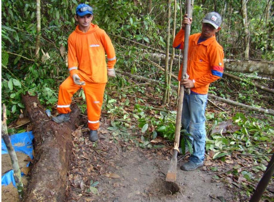
Figura 4: Ferramenta utilizada para tentar romper a crosta laterítica encontrada no furo ITC-03 a 4,0 metros de profundidade.
