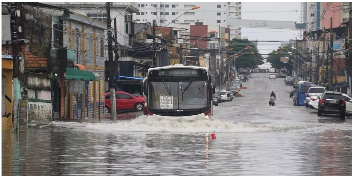
Figura 3 – Alagamento na rua Mauriti, em Belém-PA
