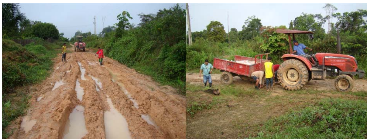
Figura 4 – Detalhe da condição precaríssima do ramal conhecido como Linha Geodésica 2 (esquerda), ao longo do qual só foi possível trafegar com o trator agrícola (direita) que serviu de transporte diário da equipe técnica até o local dos trabalhos de campo.
