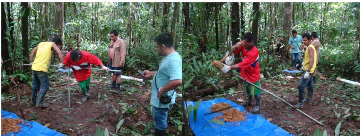
Figura 6 – Aspectos da perfuração e do material retirado do furo 06, em área de floresta primária.
