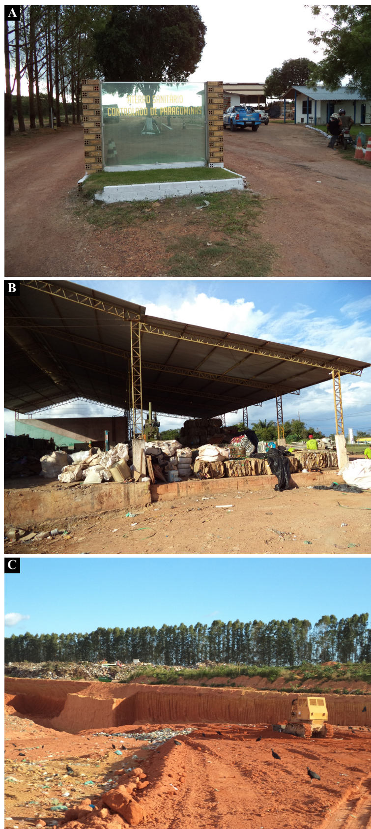
Figura 3 - Aspectos positivos do Aterro Sanitário Controlado de Paragominas: (A) Entrada do terreno, com controle de acesso; (B) Galpão da cooperativa de catadores, onde é feita a triagem da coleta seletiva; (C) Recobrimento diário dos resíduos domésticos com solos argilosos retirados do próprio local.
