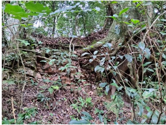
Figura 23 – Perfil de solo, colúvio/residual sobre camada alterada de rocha vulcânica básica no ponto de campo número 23.
