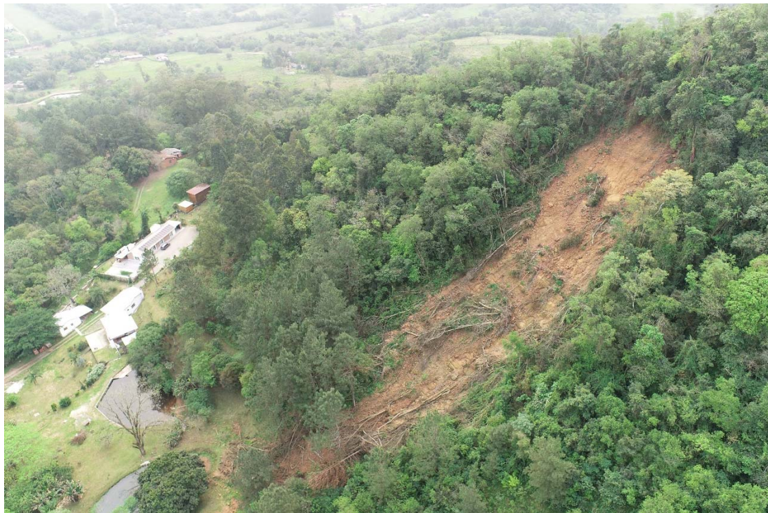
Figura 22 – Imagem de cicatriz de deslizamento ocorrido no evento pluviométrico elevado no município em abril/maio de 2024, observado na área de expansão 5 durante as atividades de campo.
