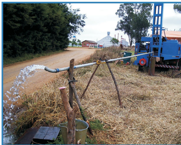
Figura 19. Poço durante o ensaio de bombeamento
