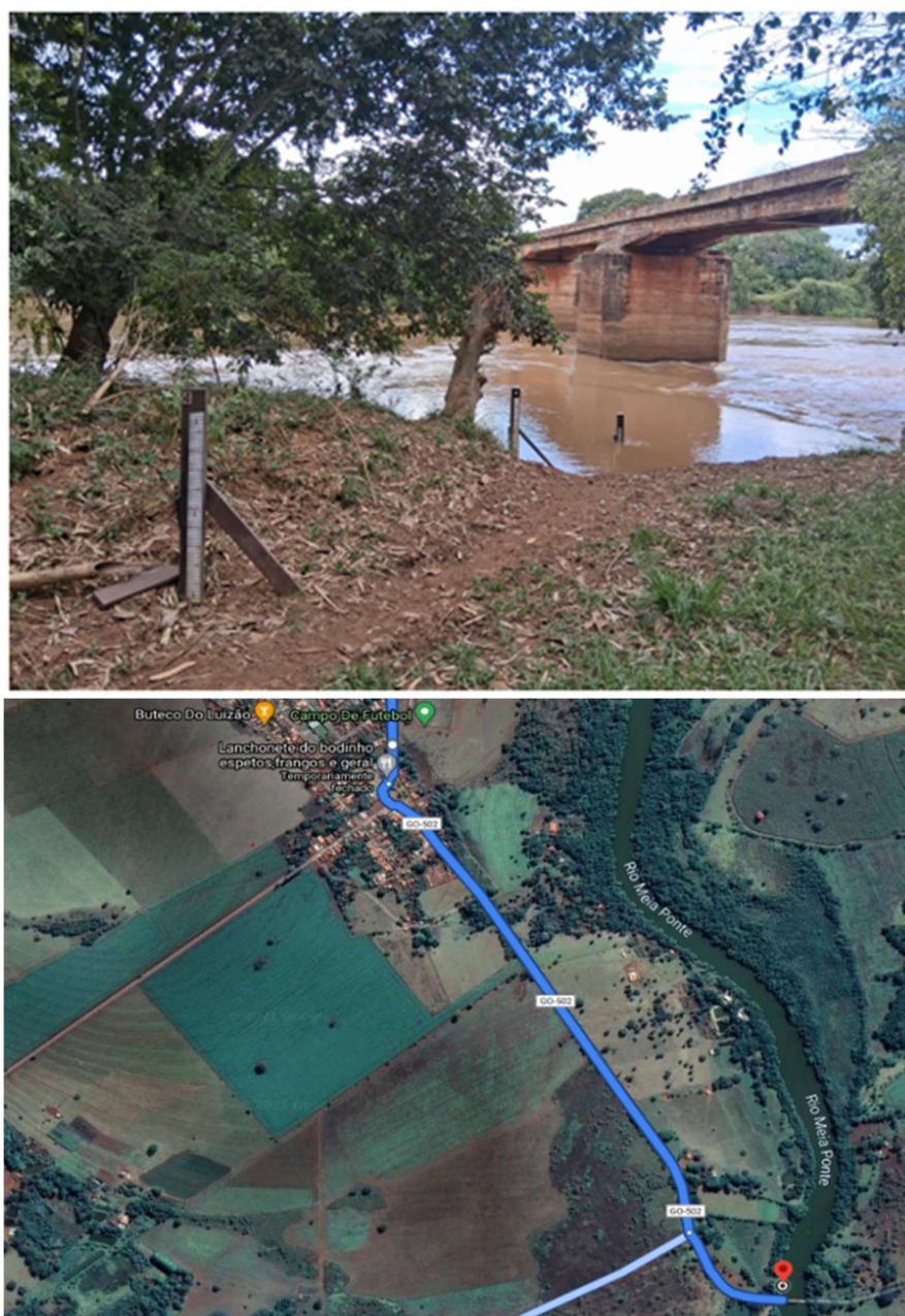
Figura 2 - Localização da seção de réguas da estação fluviométrica de Ponte Meia Ponte. Fonte: Google Earth (2024) e arquivo fotográfico do Projeto da RHN.
