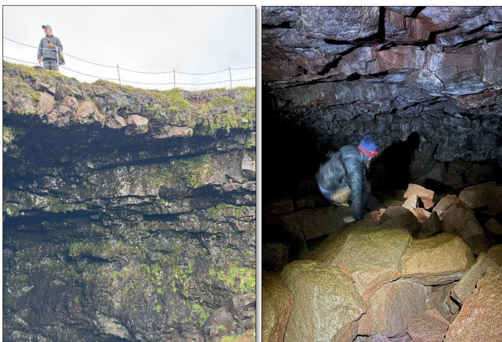
Figura 68 - Blocos de rocha com risco de desprendimento no tubo de lava de Anarker.
