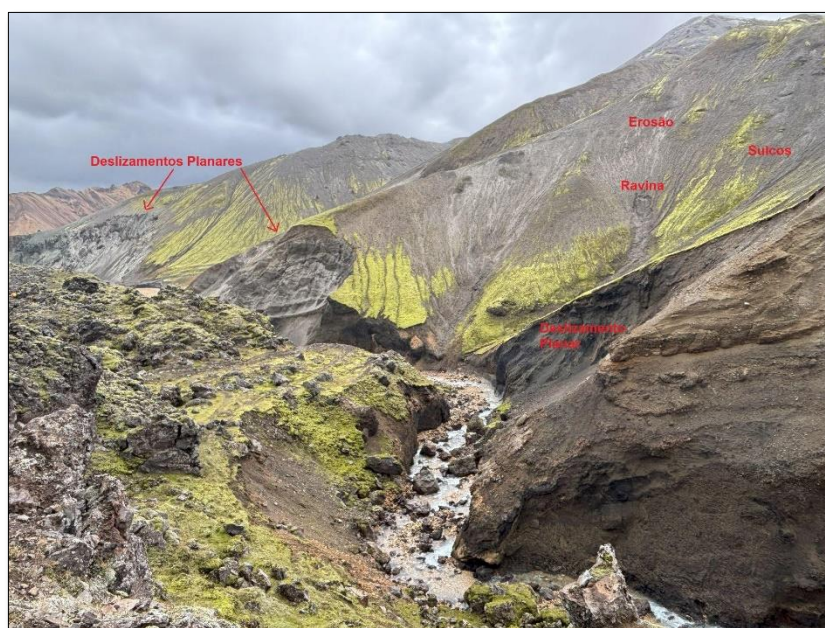
Figura 70 - Cicatrizes de deslizamento planar e feições erosivas como sulcos e ravinas em rochas piroclásticas.
