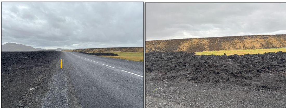
Figura 65 – Registro do fluxo de lava que atravessou a estrada e alcançou o dique de contenção.
