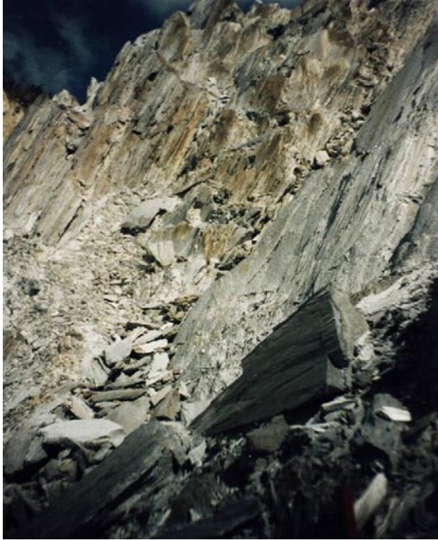
Figura 3.3 – Parte de talude em filito prateado, Formação Cercadinho, Grupo Piracicaba, localizado na Av. Raja Gabaglia – Belo Horizonte. Detalhe para blocos de dimensões centimétricas a decimétricas, soltos na porção inferior da foto. As superfícies de xistosidade são bastante evidentes.
