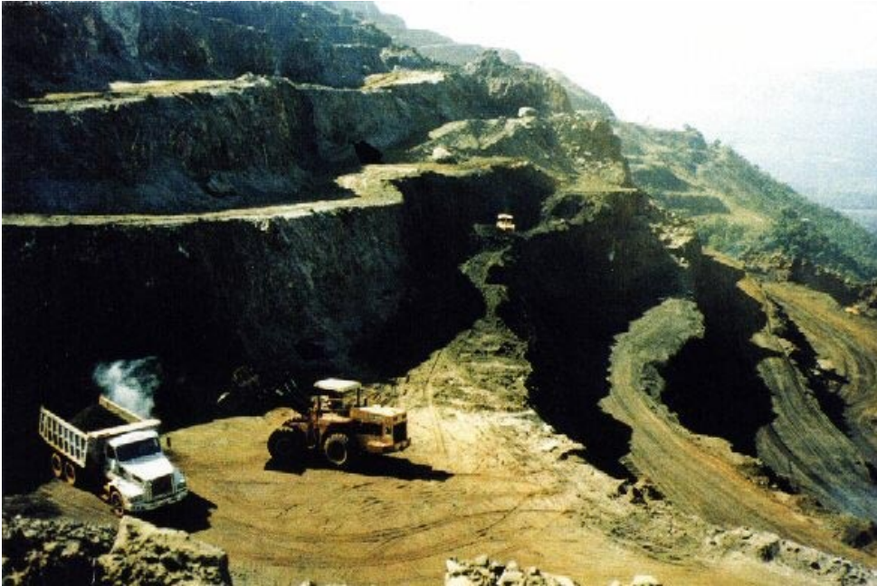
Figura 2.7 - Parte do talude constituído por itabirito mole, intercalado por hematita compacta e hematita pulverulenta, mapeado na Mina de Água Santa. Observa-se que o equipamento de escavação possui dimensões pequenas, relativamente à altura do banco lavrado. Nota-se que a altura do banco em operação é maior do que a altura do banco superior. Esta diferença também pode ser observada com relação aos bancos inferiores.
