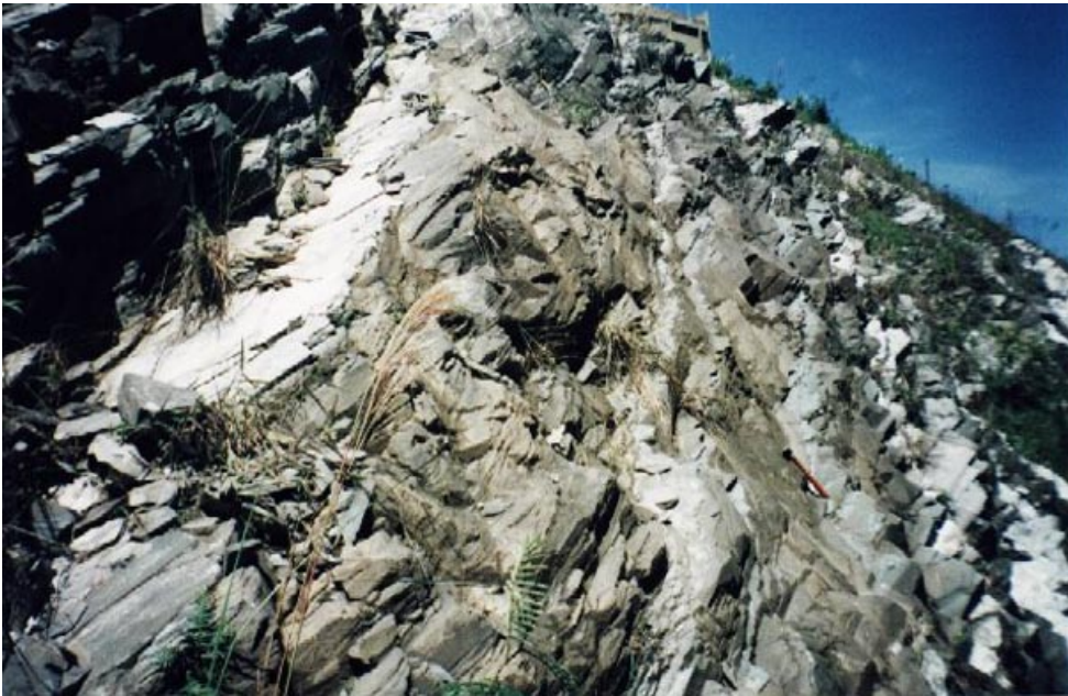
Figura 3.4 – Porção de talude em quartzito (Formação Cercadinho, Grupo Piracicaba), localizado na Av. Raja Gabaglia, Belo Horizonte. Detalhe para o padrão de fraturamento exibido e para a construção de moradia, na região da crista do talude.
