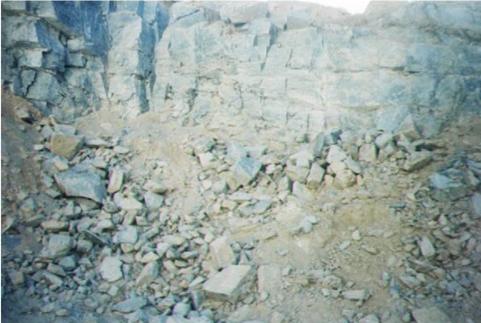
Figura 4.25 – Talude em gnaisse, mapeado na Pedreira 12. Percebe-se fraturamento intenso exibido pela rocha, evidenciado pelo processo de desmonte a explosivo.
