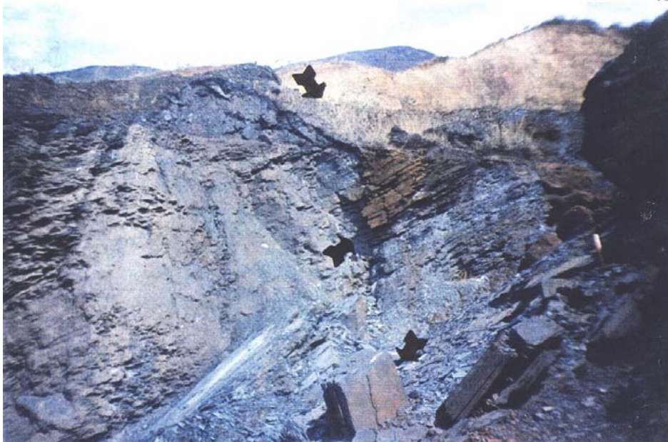
Figura 2.5 - Talude 05, mapeado na Mineração Itanorte. Constitui-se por itabirito mole, que se rompe tanto em placas quanto em blocos (porção inferior direita da foto), evidenciando processos de ruptura planar. Encontra-se muito alterado, o que é evidenciado pela coloração avermelhada das superfícies de xistosidade/acamamento, e pela ausência dos leitos de quartzo, que gera espaços vazios entre as camadas de hematita. Na porção superior da foto nota-se saprólito, provavelmente originário de filito.
